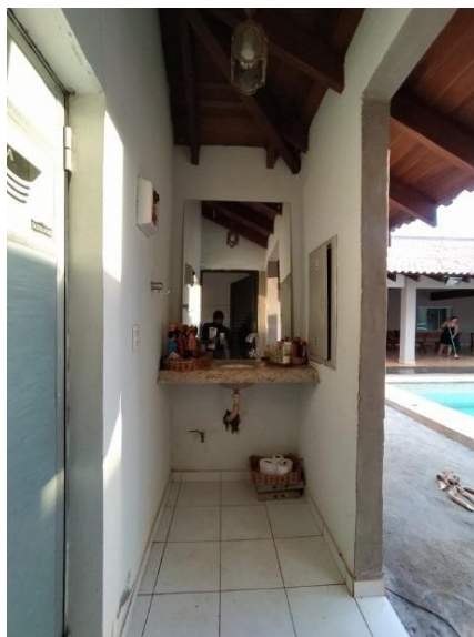
Representação Piscina Descrição Lavatório Data Foto 11/12/2020
