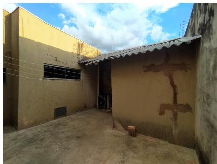
Representação Lavanderia Descrição Vista da despensa/ lavanderia Data Foto 11/12/2020
