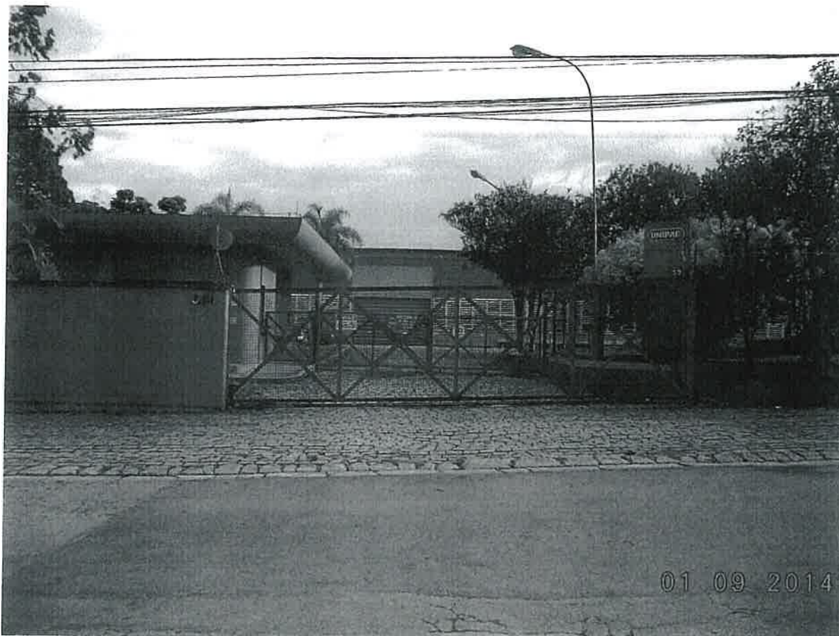
Foto 1 - Fachada Principal - Rua Arnaldo Magniccaro 521
