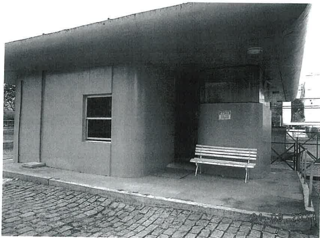
Foto 22 - Prédio 4 - Portaria - vista de dentro do imóvel
