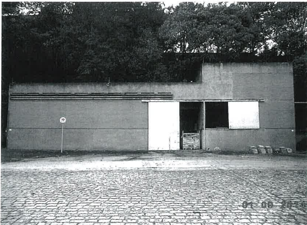
Foto 32 - Prédio 9 - Ferramentaria - Corte de Tubos
