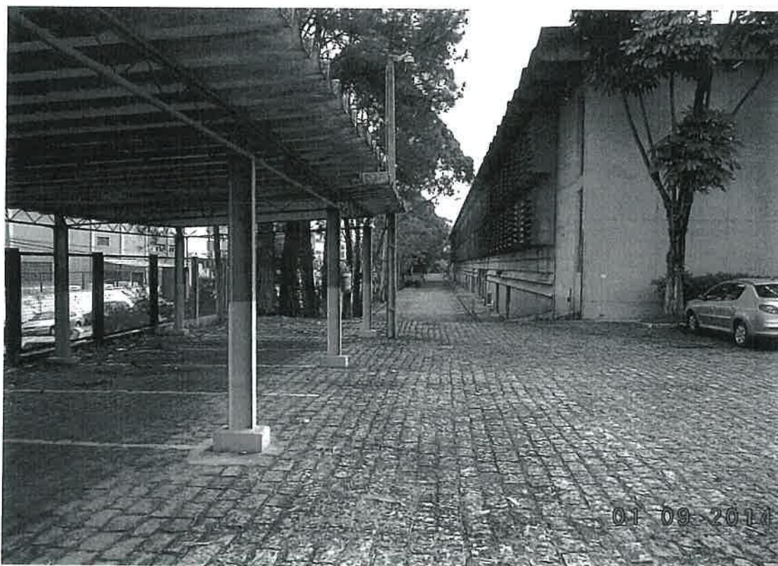
Foto 19 - Prédio 2 - Cobertura aberta
