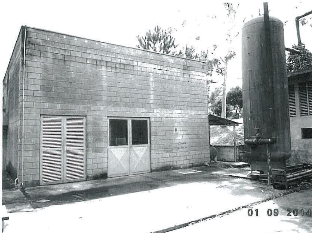
Foto 37 - Prédio 13 - Sistema de Ar Comprimido
