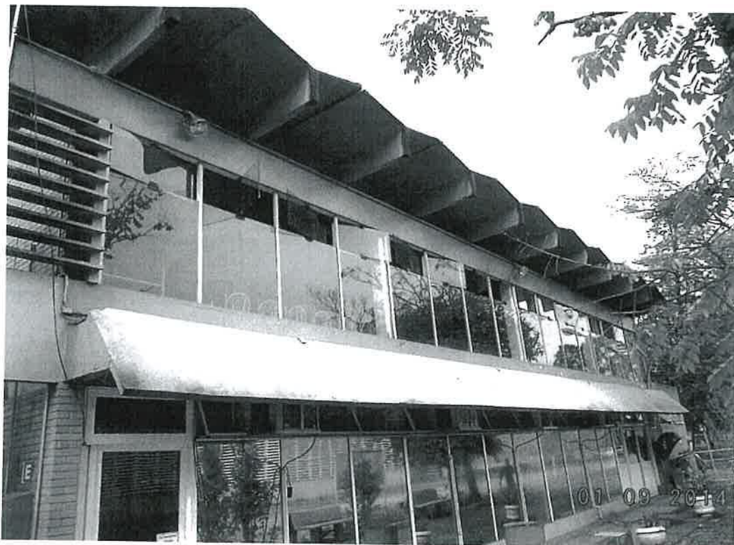
Foto 24 - Prédio 6 - Pavimento térreo - Refeitório e Cozinha
