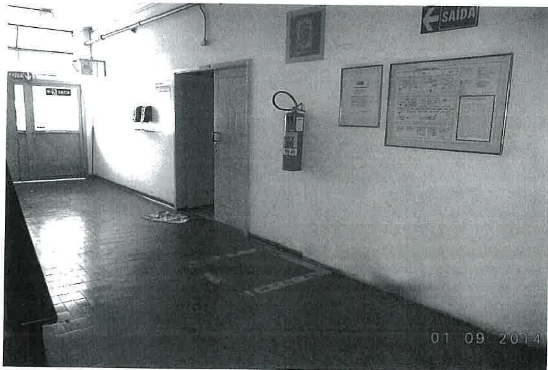
Foto 12 - Entrada do vestiário
