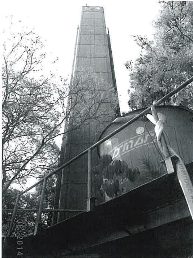
Foto 31 - Prédio 8 - Caixa D'água
