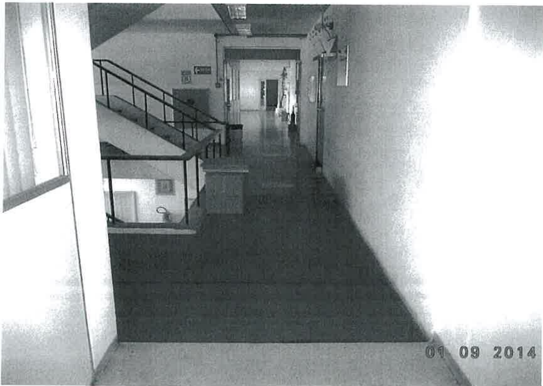
Foto 7 - Acesso escadas internas
