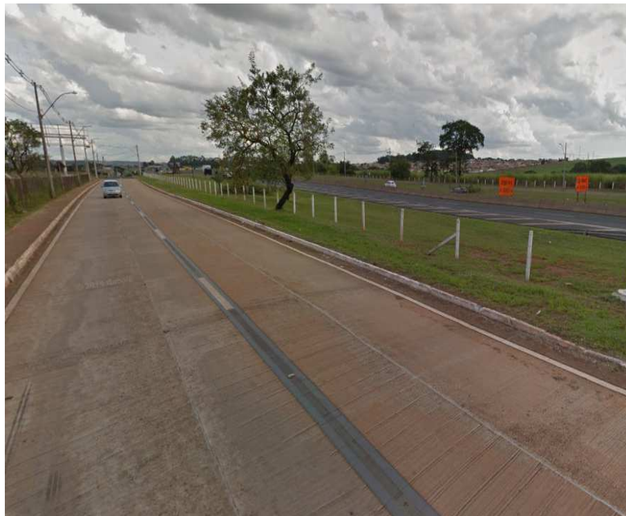
VISTA DA GLEBA "C".
