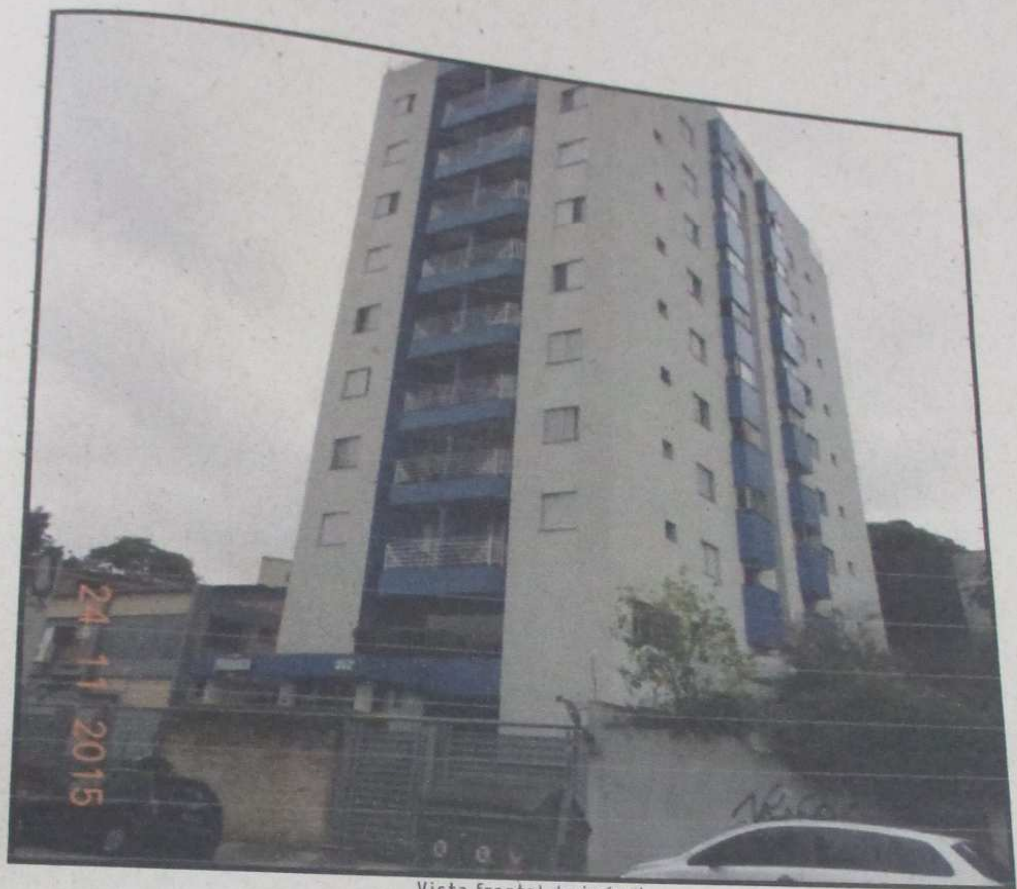
Vista frontal do imóvel
