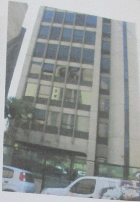
Foto 01 – Frente do imóvel avaliando, Rua Beira Rio, 57
