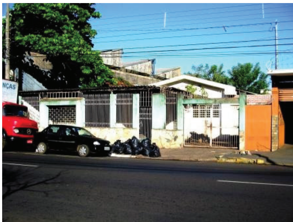
Foto 18 – Vista de frente do imóvel periciado, a partir da Avenida Saudade.
