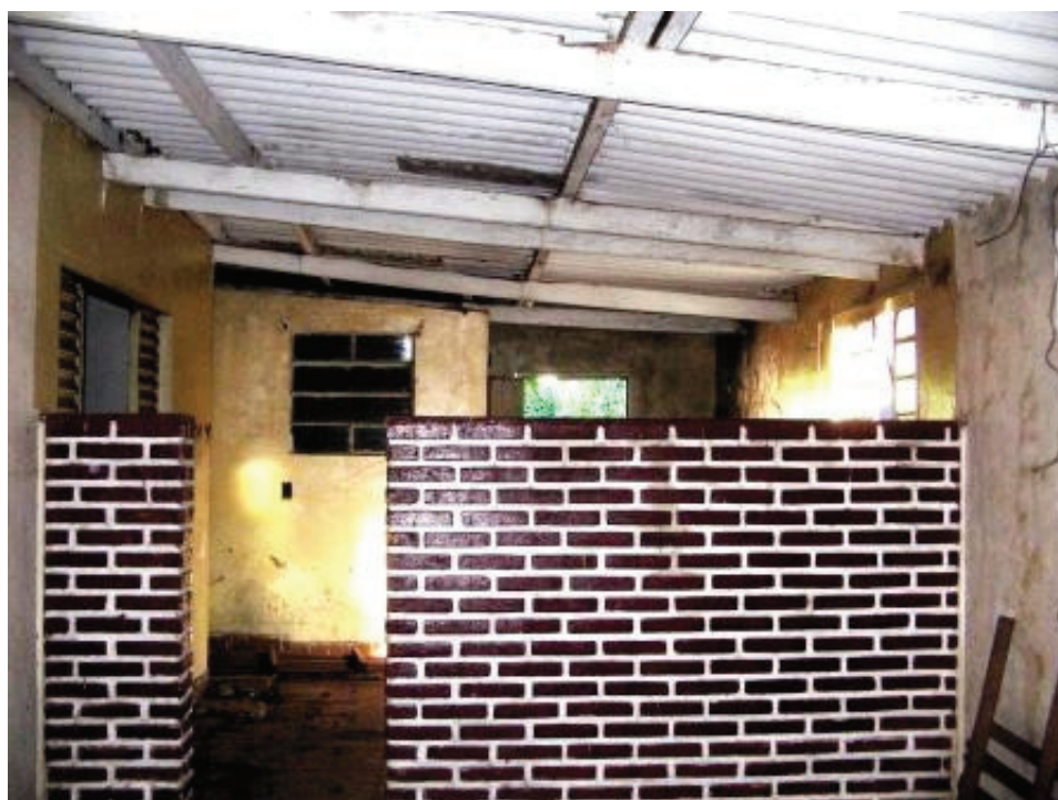
Foto 8 – Edificação da frente. Interior do ambiente denominado “Salão” na planta do Anexo II.
