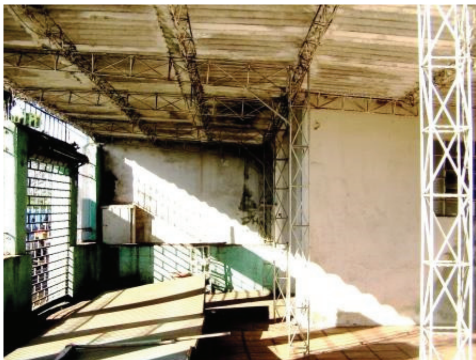
Foto 2 – Observador no mesmo ponto da foto anterior, agora porém olhando lateralmente, vendo a cobertura da frente do imóvel (vide planta do ANEXO II)
