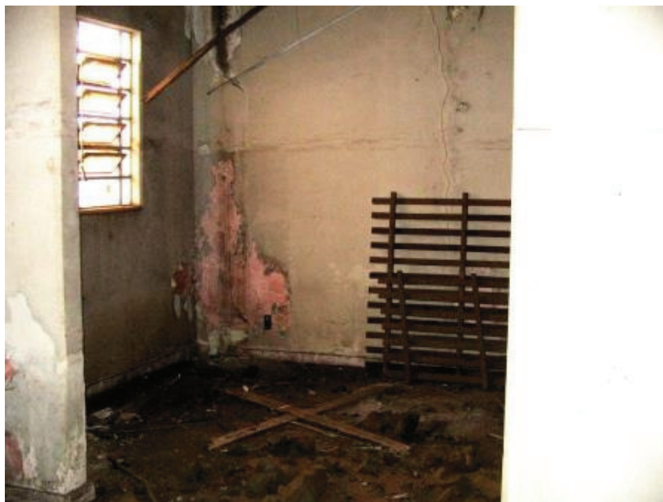
Foto 13 – Edificação do fundo: Copa
