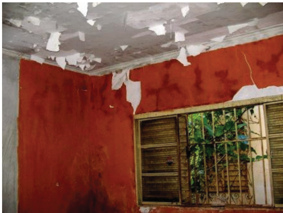
Foto 6 – Edificação da frente: interior da sala da esquerda.
