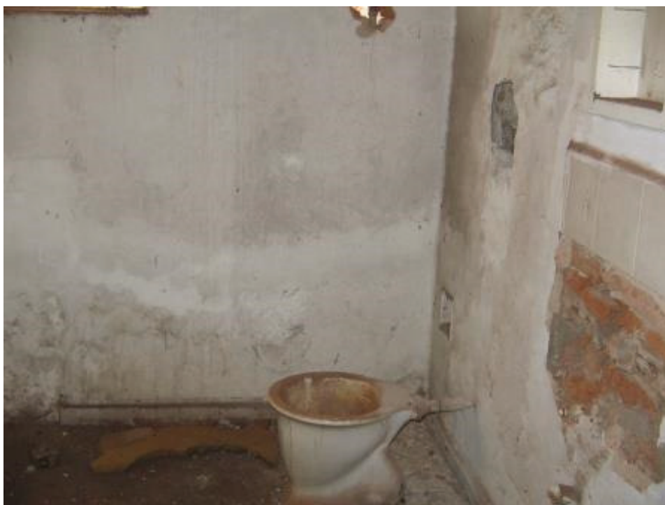
Foto 16 – Edificação do fundo: Banheiro
