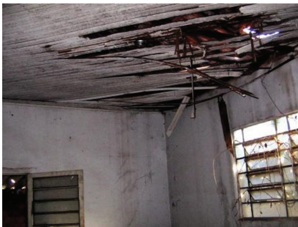
Foto 14 – Edificação do fundo: Sala
