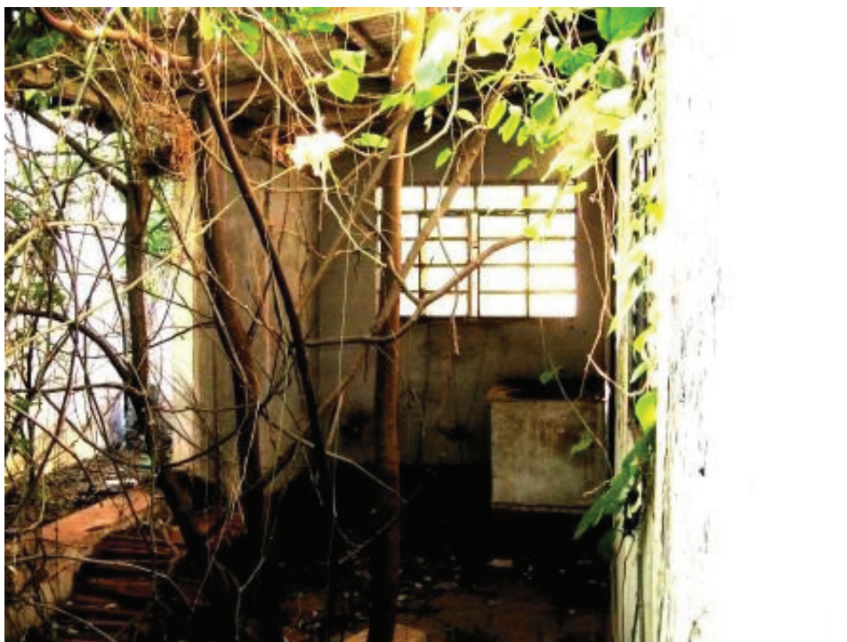
Foto 12 – Edificação do fundo: Área de serviço
