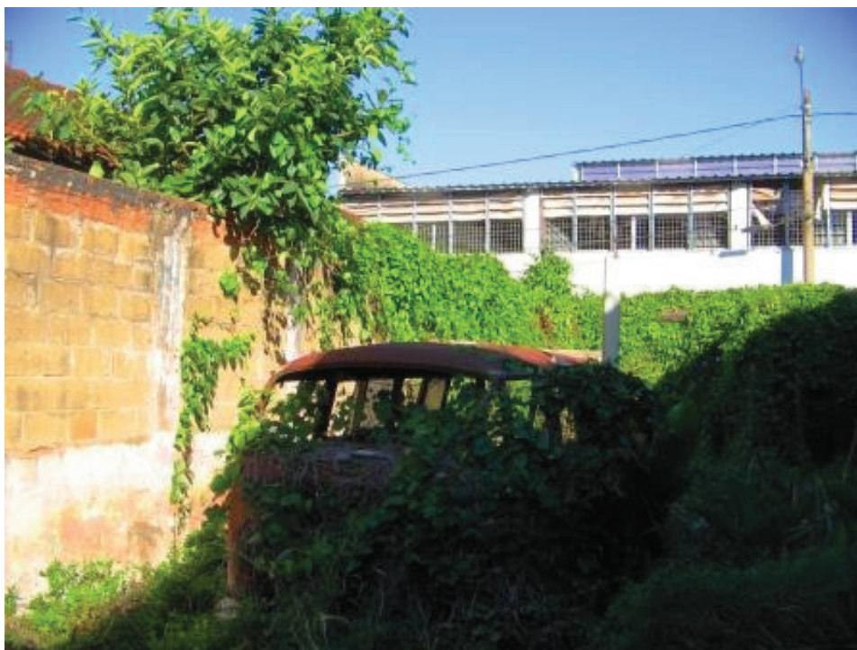
Foto 11 – Espaço descoberto, atrás da edificação da frente e à direita da edificação do fundo, vendo-se também o muro que divide as duas edificações no lado esquerdo da foto.
