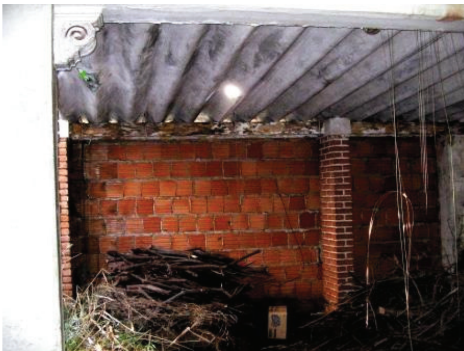
Foto 15 – Edificação do fundo: Varanda
