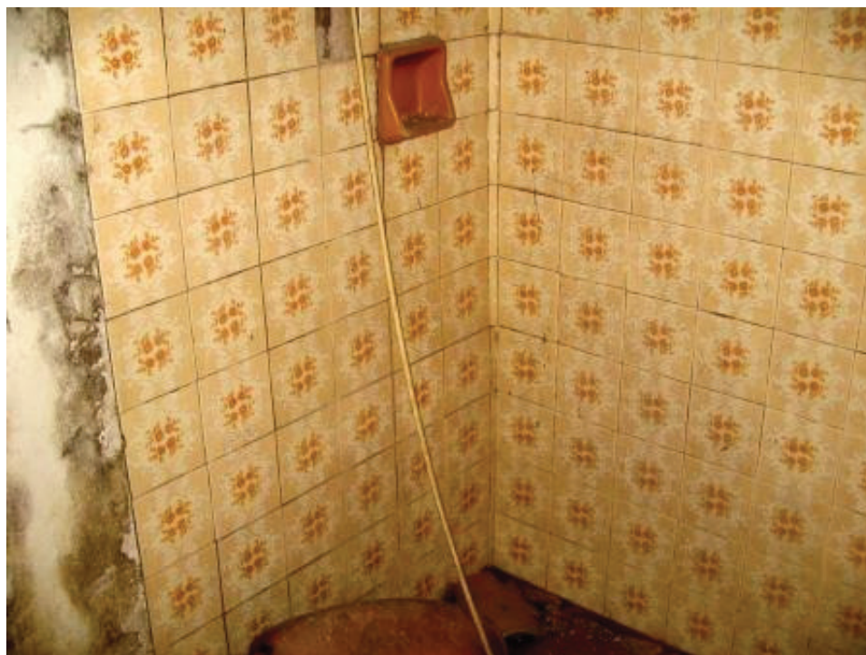
Foto 9 – Edificação da frente: Banheiro situado entre o hall e a cozinha.
