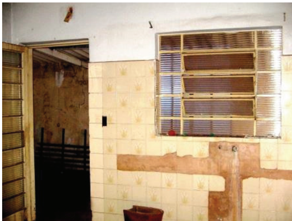
Foto 7 – Edificação da frente. Interior da cozinha.
