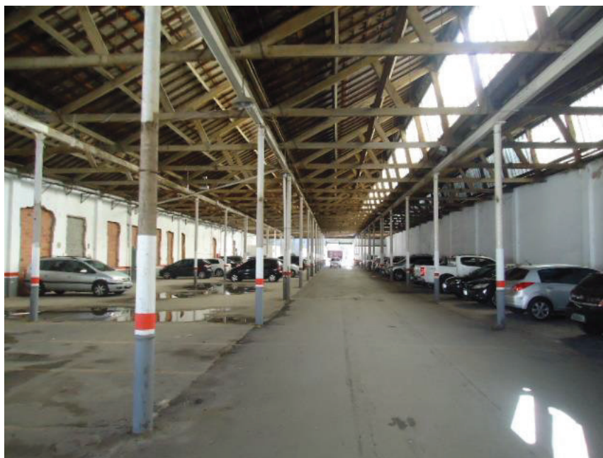
FOTO N° 21: Vista parcial interna do estacionamento.
