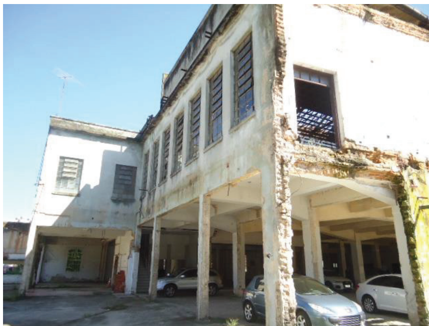
FOTO N° 27: Vista da fachada da edificação.
