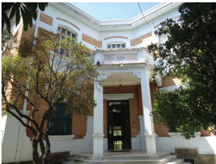
FOTO N° 04: Vista da fachada da edificação principal.
