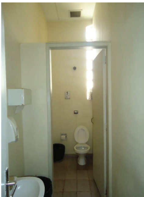
FOTO N° 16: Vista geral do WC.
