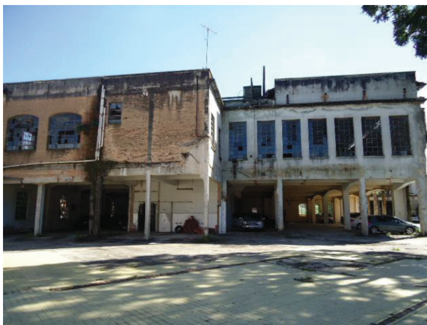
FOTO N° 24: Vista das fachadas das edificações.
