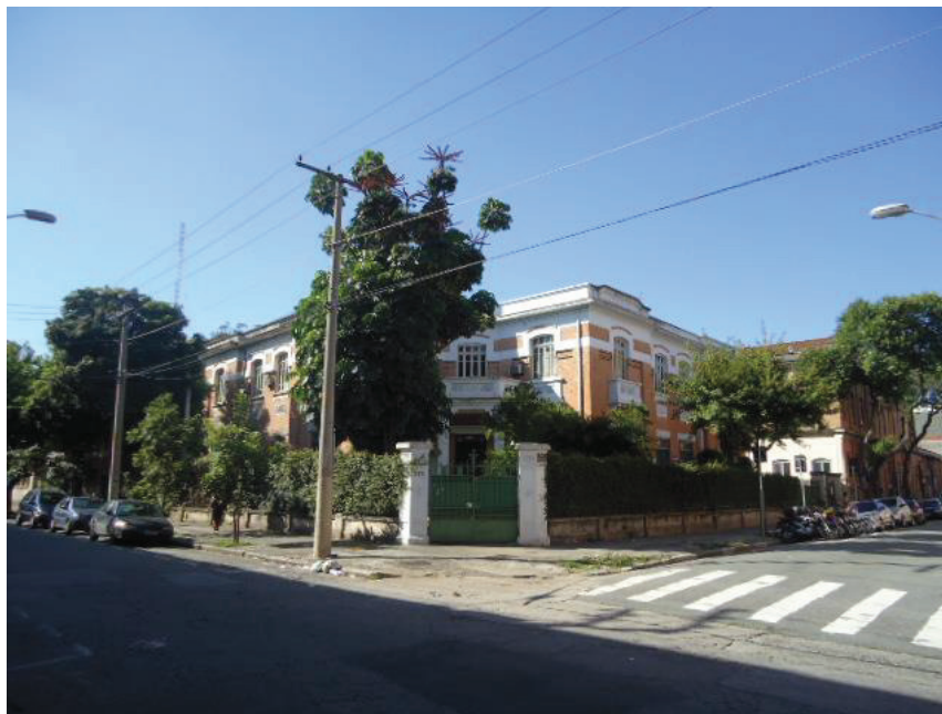
FOTO N° 01: Vista da fachada do imóvel avaliando, localizado na Rua Joli, nº. 273 – Brás, São Paulo/SP.
