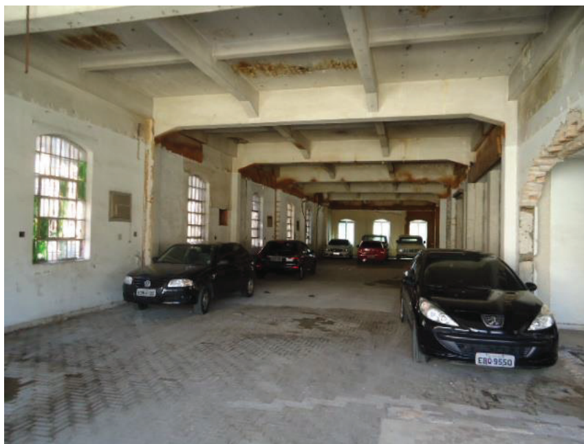
FOTO N° 25: Vista interna da edificação.
