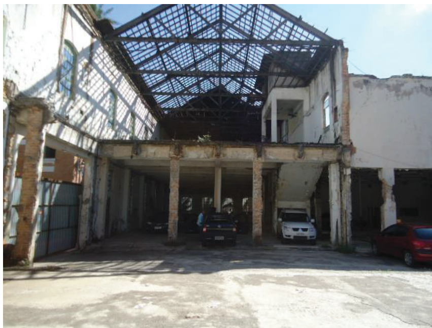
FOTO N° 29: Outra vista do imóvel avaliando.
