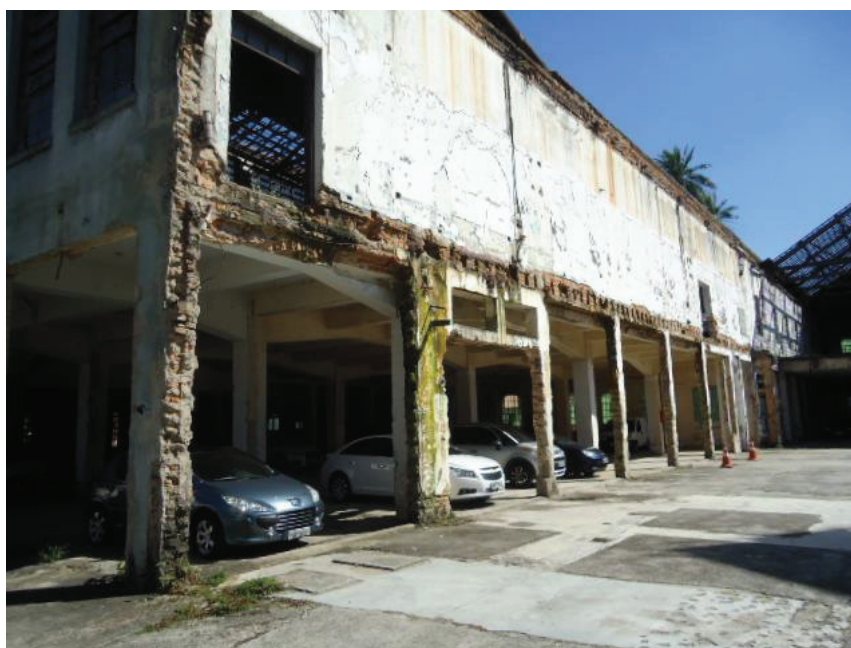
FOTO N° 28: Vista da fachada lateral da edificação.
