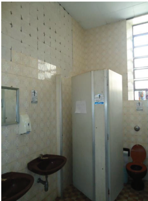
FOTO N° 07: Vista parcial do WC.
