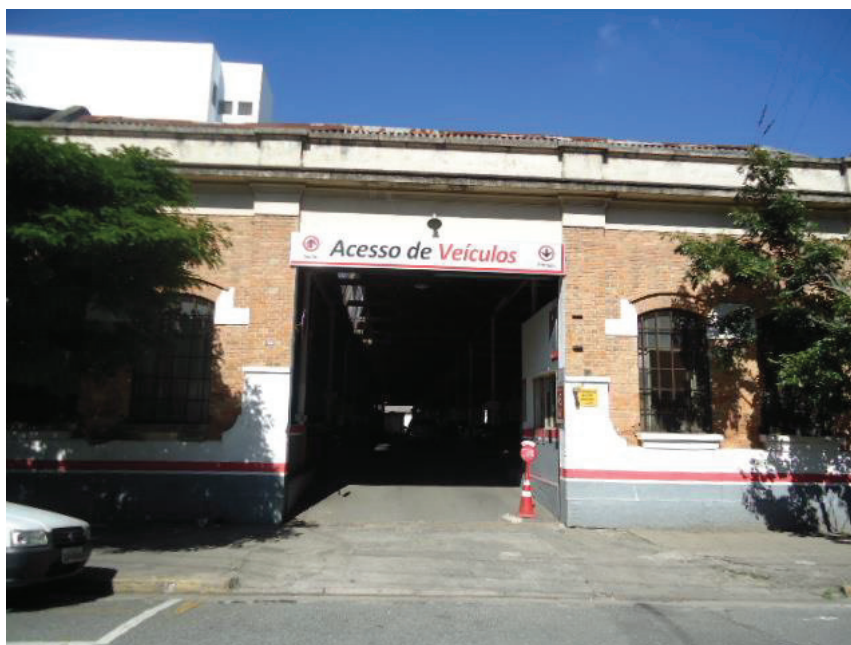
FOTO N° 20: Vista da fachada frontal da edificação, entrada do estacionamento pela Rua Joli, nº. 165.
