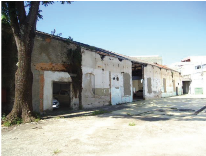
FOTO N° 23: Vista lateral da fachada do galpão (Estacionamento).
