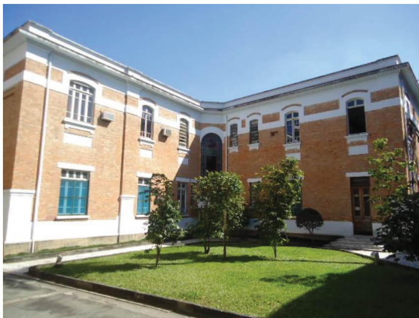
FOTO N° 19: Vista geral do jardim e fachada dos fundos da edificação.
