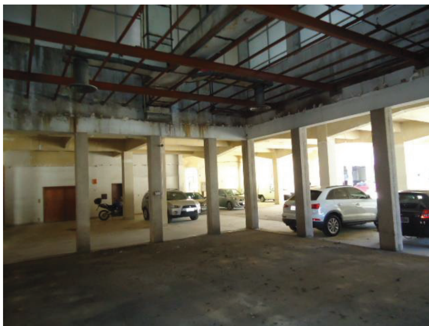
FOTO N° 26: Vista interna da edificação.
