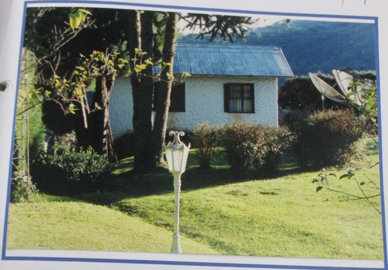
Foto 7 – Detalhe da edícula existente no lote avaliando, notando-se as suas características construtivas.
