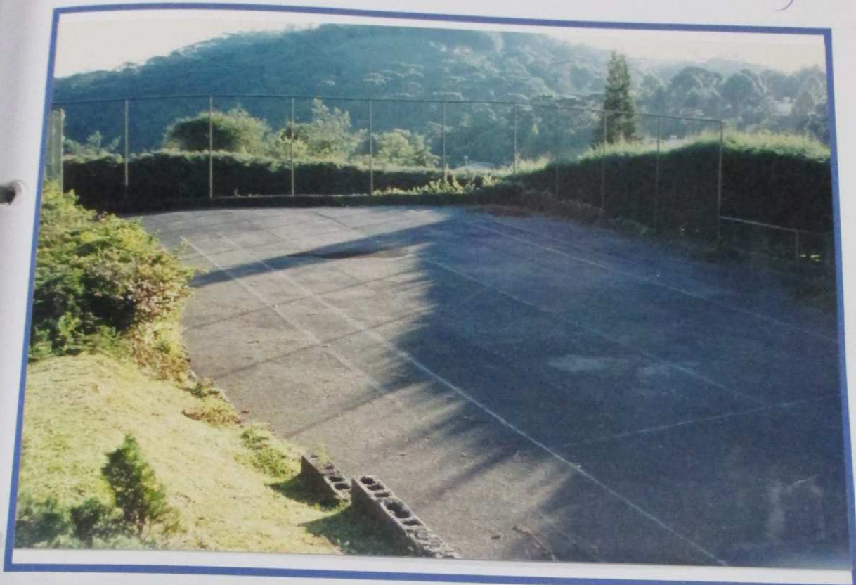
Foto 8 – Vista da quadra existente no lote 23.
