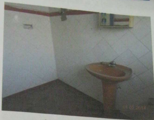
Vistas do banheiro.
