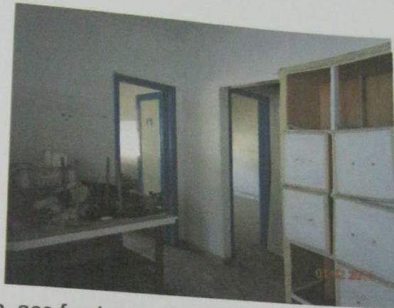
Outra vista da sala, aos fundos, os dormitórios e, o hall de distribuição à direita.
