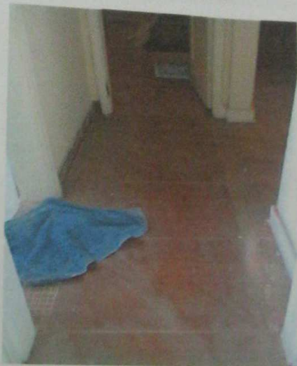
Vista do hall de distribuição.
