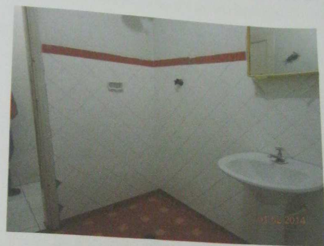
Vistas do banheiro.
