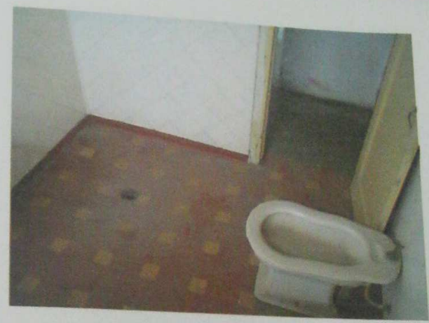
Vistas do banheiro.
