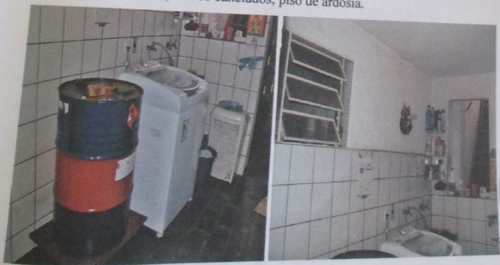
Área de serviço com teto de laje e paredes revestidas de reboco, pintura em látex, azulejo ½ barra, vidro com esquadrias de ferro tipo basculantes, vidros cancelados, piso de ardósia.
