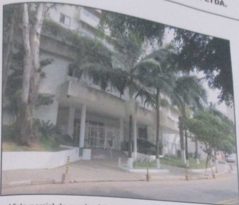
FOTO 4 – Vista parcial do condomínio Green Park. Observam-se os acessos de pedestres para moradores.
