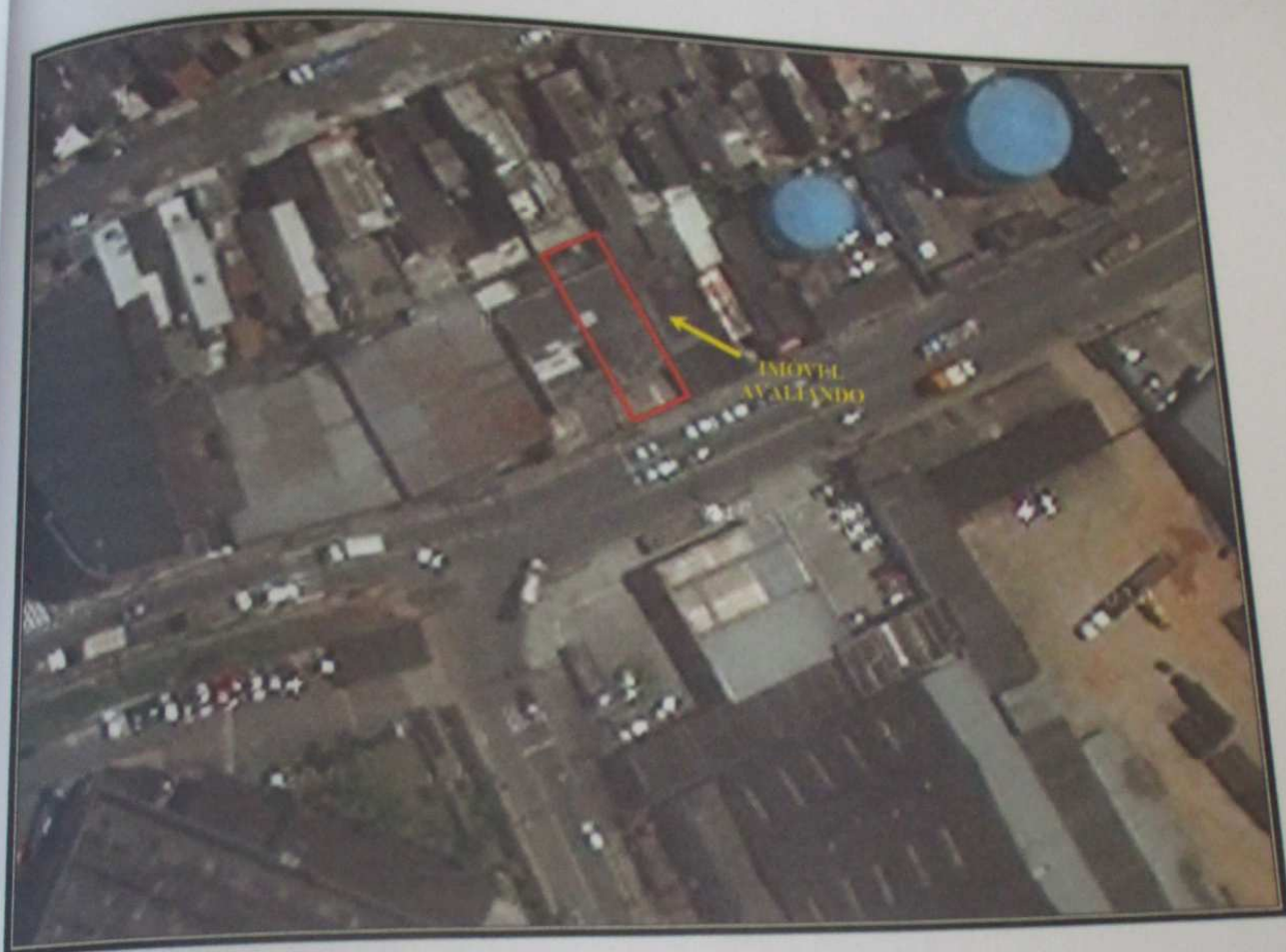
Vista aérea da região onde está situado o imóvel avaliando.
