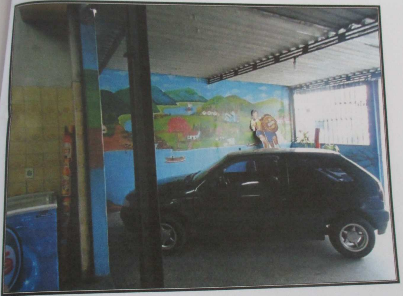
Cobertura localizada no pavimento térreo.
