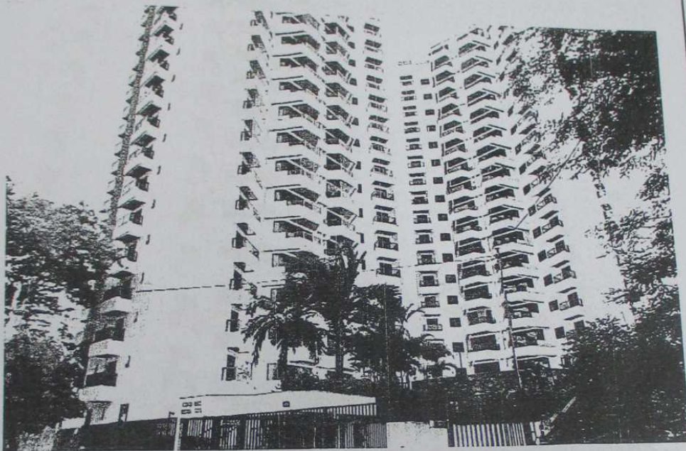
VISTA LONGITUDINAL DO CONDOMÍNIO RESIDENCIAL ROMA, ONDE ESTÁ LOCALIZADA A VAGA DE GARAGEM Nº 64/65.
