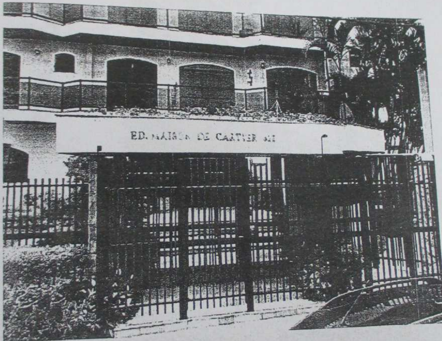
VISTA DA ENTRADA DO EDIFÍCIO MAISON DE CARTIER, ONDE ESTÃO LOCALIZADAS AS VAGAS DE GARAGEM DE Nº G16 E G8.
