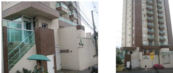
Fachada do prédio
