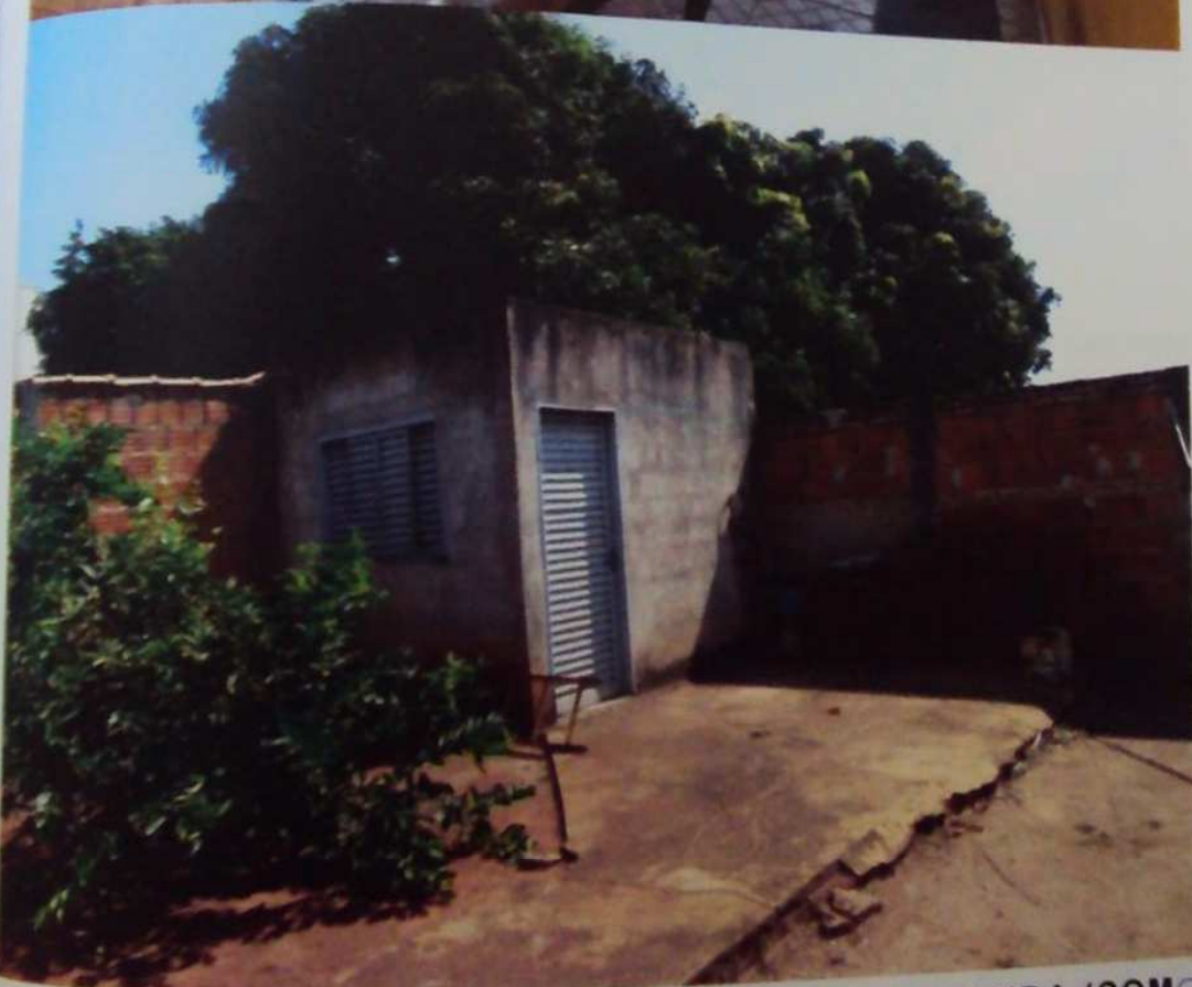
VISTAS DA RESIDÊNCIA OBSERVANDO-SE A VARANDA (COM ÁREA DE SERVIÇO) E O DESPEJO.
