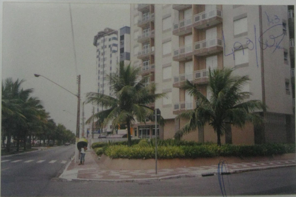
F2 – Aspecto do Conjunto Residencial das Praias, do apartamento nº 531 avaliando, vendo-se a Av Presidente Castelo Branco que acompanha a orla marítima e a vizinhança com edifício de apartamentos.
