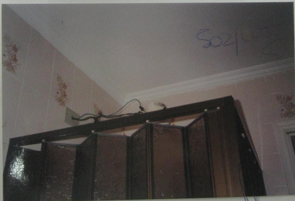
F11 – Interior do banheiro com Box de acrílico e alumínio anodizado, forro em massa corrida e látex, e moldura de gesso.
