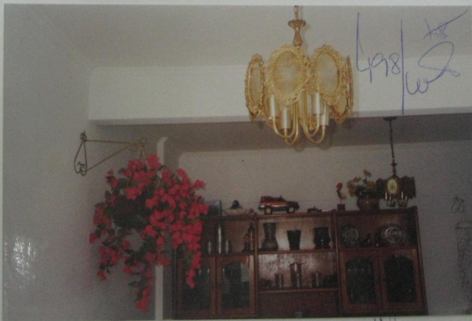
F7 – Aspecto da sala de estar com paredes e forro revestidos de massa corrida e látex.
