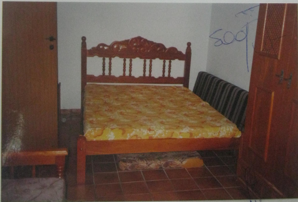
F9 – Interior do dormitório, observando-se o piso cerâmico e paredes revestida com massa corrida e látex..
