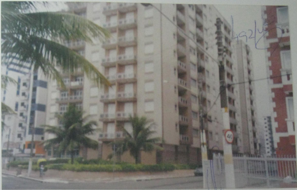
F1 – fachada lateral do Edifício saquarema – Bloco C , do apartamento avaliando nº 531, na Avenida Presidente Castelo Branco esquina com rua Monteiro Lobato
