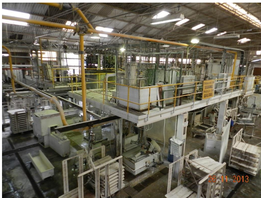
Vista da unidade de prensagem de massa isolante.
