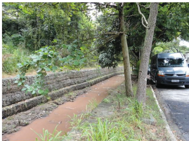
Foto 04 – Vista do córrego na frente dos imóveis
