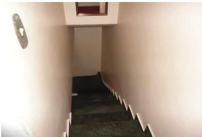
Foto 16 – Vista da escada (piso superior)
