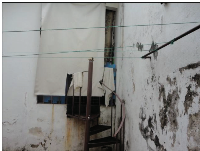
Foto 09 – Escada de acesso a edícula
