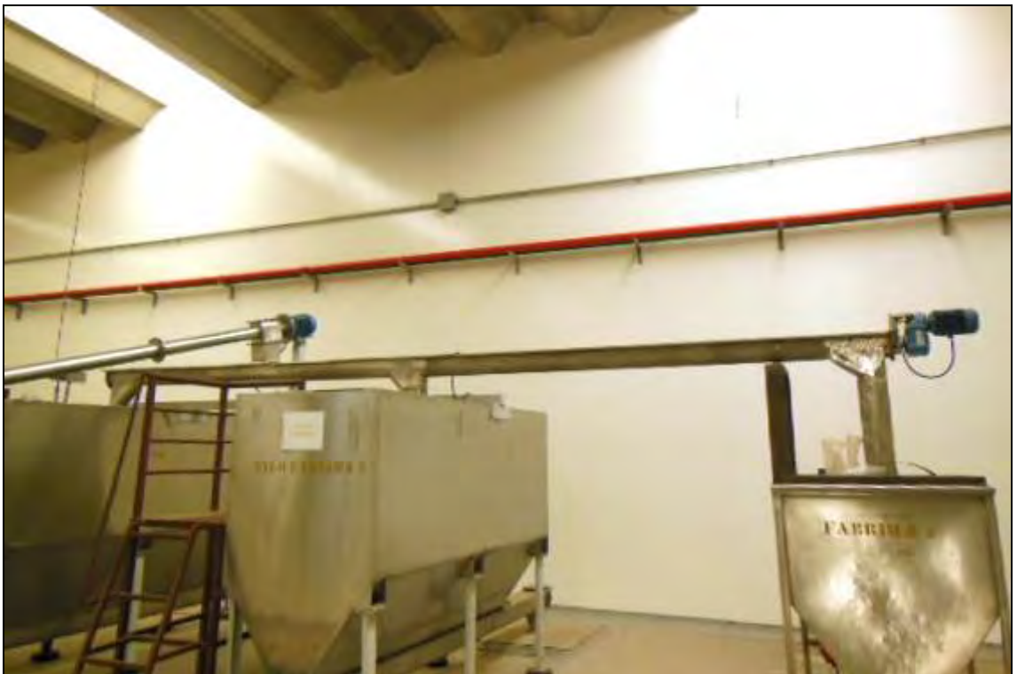
ITEM 1,031 – VISTA DA ROSCA TRANSPORTADORA EM ALUMINIO ACIONADA POR MOTOR REDUTOR PARA ALIMENTAÇÃO DOS SILOS FABRICA N° 1, 2 E 3
