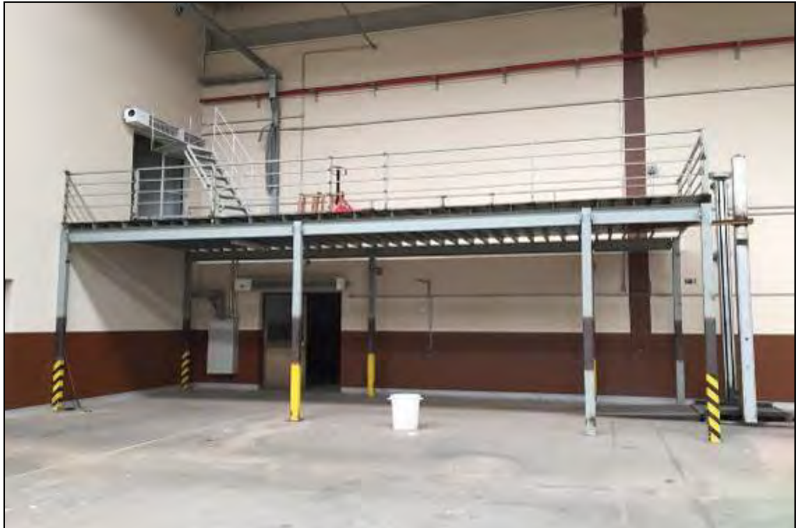
ITEM 1,092 – VISTA DO MEZANINO EM AÇO CARBONO COM CHAPA E SUPORTE COMPRIMENTO: 1200 MM LARGURA: 4000 MM
