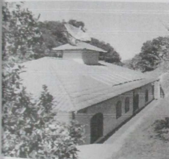
Predio com aquecedor solar
