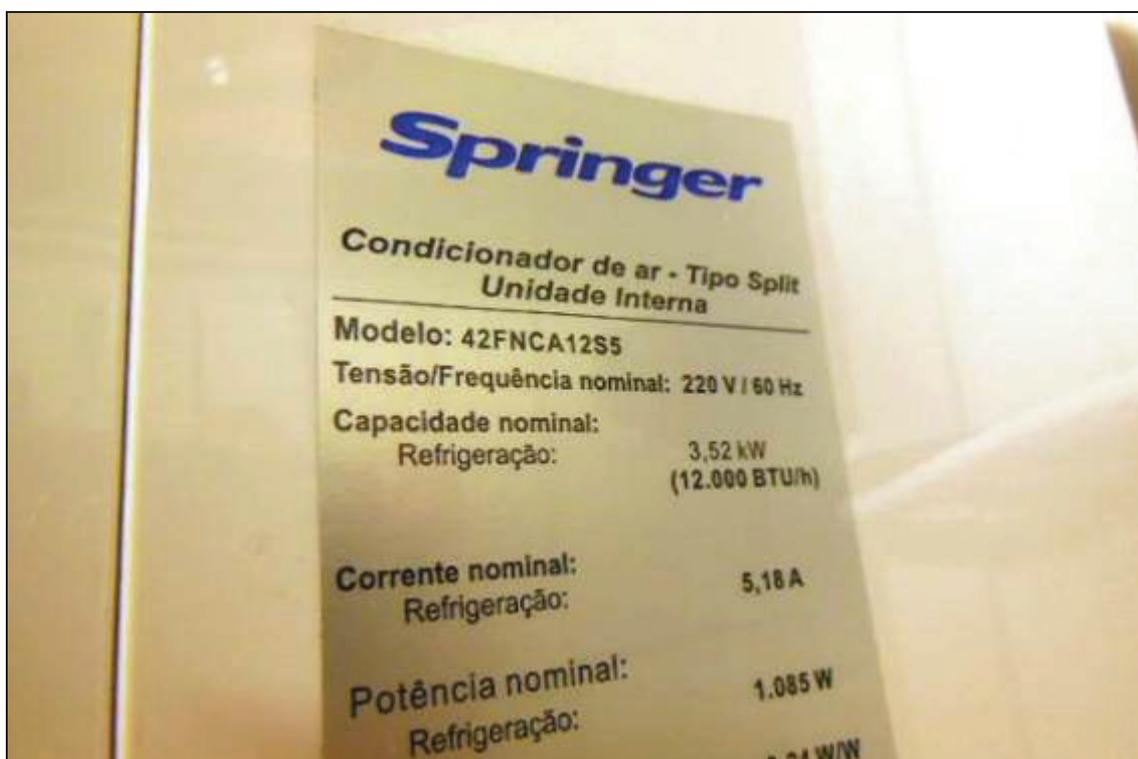
ITEM 1,011 – VISTA DA ETIQUETA DE IDENTIFICAÇÃO DO AR CONDICIONADO MARCA: SPRINGER CARRIER MODELO: SPLIT HI WALL POTÊNCIA: 12.000BTU SÉRIE: 42FNCA12S5
