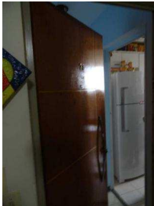
VISTA DA PORTA DE ENTRADA DO APARTAMENTO DE Nº 73 DO BLOCO C.
