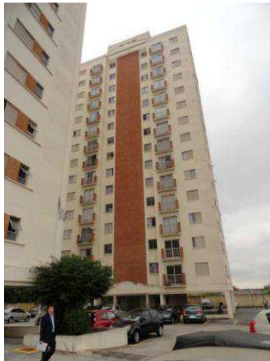
VISTA DO BLOCO D.
