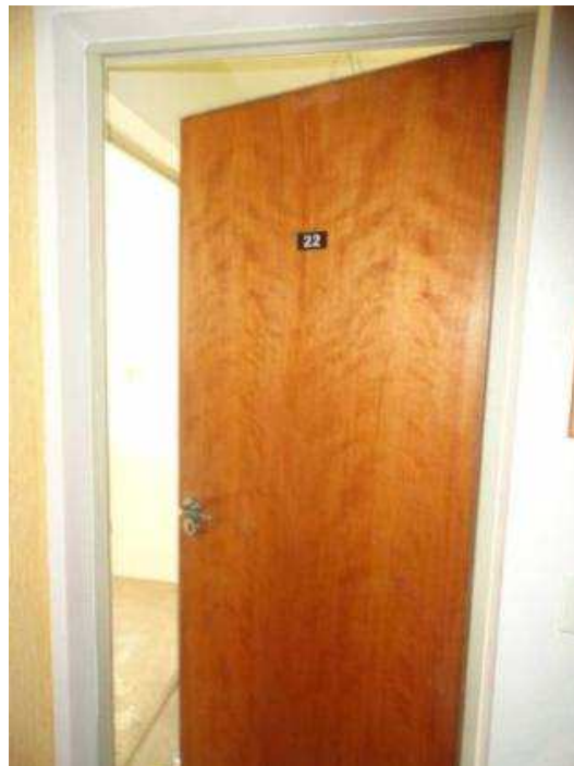
VISTA DA PORTA DE ENTRADA DO APARTAMENTO DE Nº 22 DO BLOCO C.
