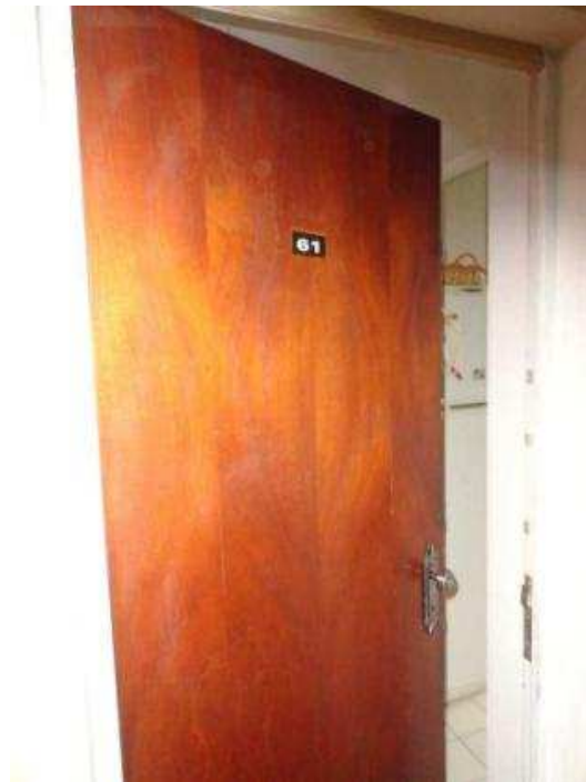
VISTA DA PORTA DE ENTRADA DO APARTAMENTO DE Nº 61 DO BLOCO A.
