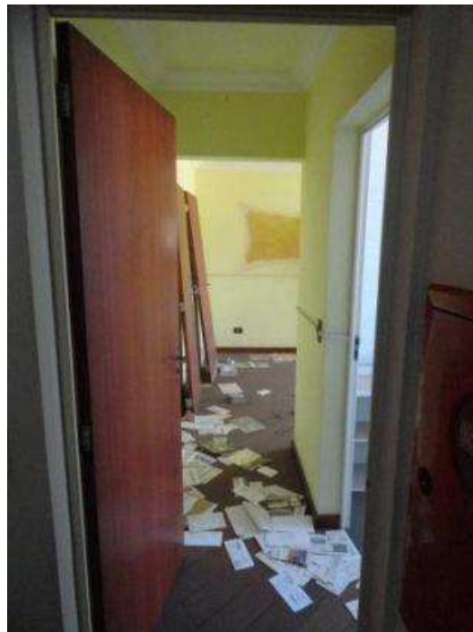
VISTA DA PORTA DE ENTRADA DO APARTAMENTO DE Nº 43 DO BLOCO D.
