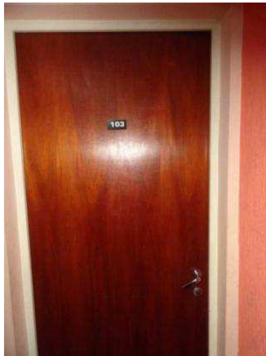
VISTA DA PORTA DE ENTRADA DO APARTAMENTO DE N° 103 DO BLOCO A.
