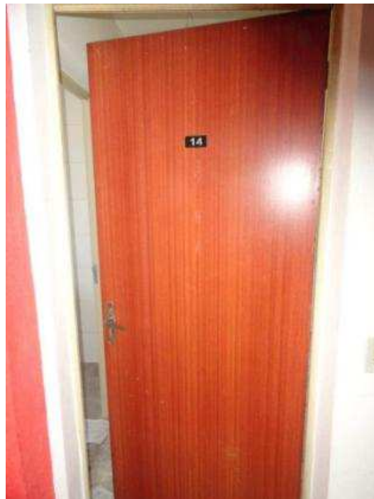
VISTA DA PORTA DE ENTRADA DO APARTAMENTO DE Nº 14 DO BLOCO D.
