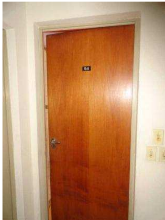
VISTA DA PORTA DE ENTRADA DO APARTAMENTO DE Nº 54 DO BLOCO C.
