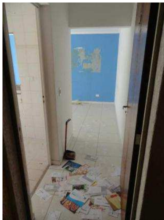
VISTA DO HALL DE ENTRADA.
