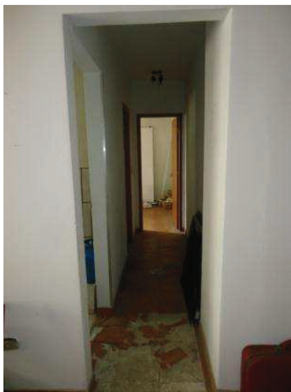
VISTA DO CORREDOR DE ACESSO ÀS DEPENDÊNCIAS INTERNAS.
