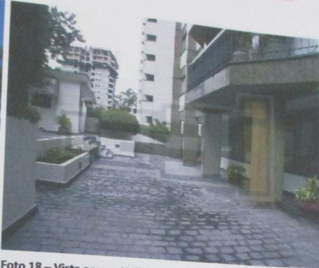
Foto 18 - Vista acesso Hall Social R3
