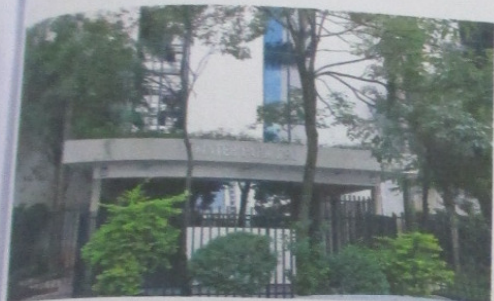
Foto 01 - Vista frontal do Empreendimento
