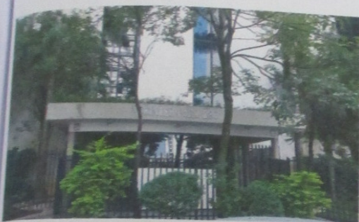
Foto 01 - Vista frontal do Empreendimento
