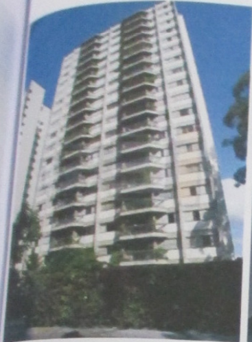
Foto 17 - Vista fachada R3
