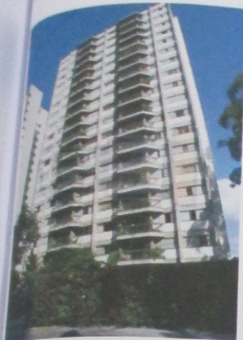
Foto 17 - Vista fachada R3
