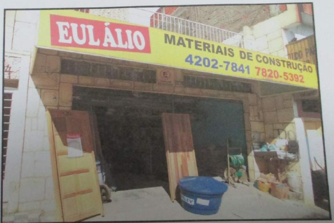
FOTOS 04/06 : Vistas do imóvel vistoriado.
