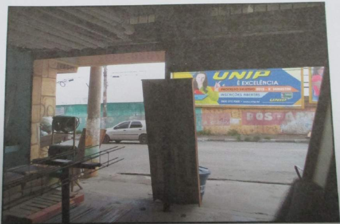
FOTOS 07/08 : Vistas do imóvel vistoriado.
