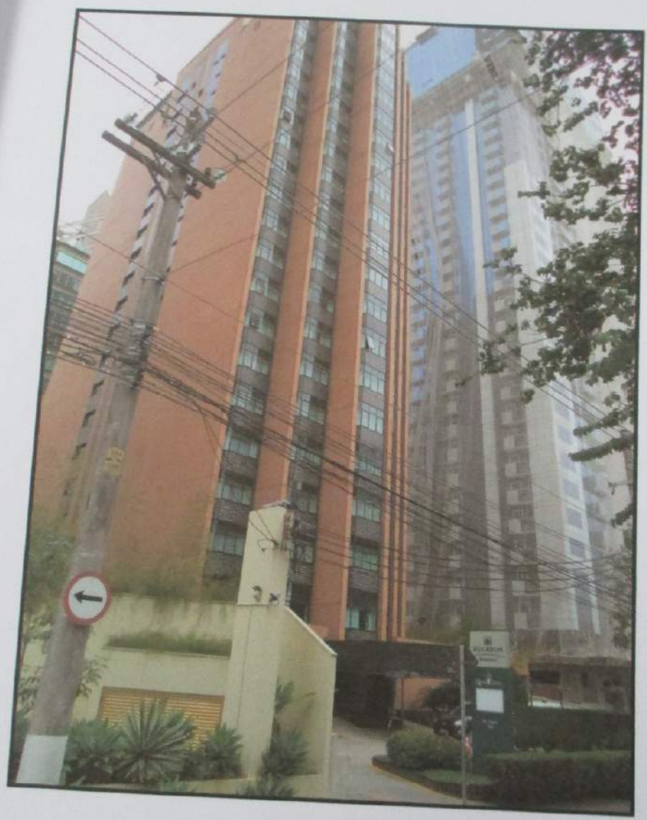
FOTO 01 : Eis o edifício que abriga a unidade avalianda.
