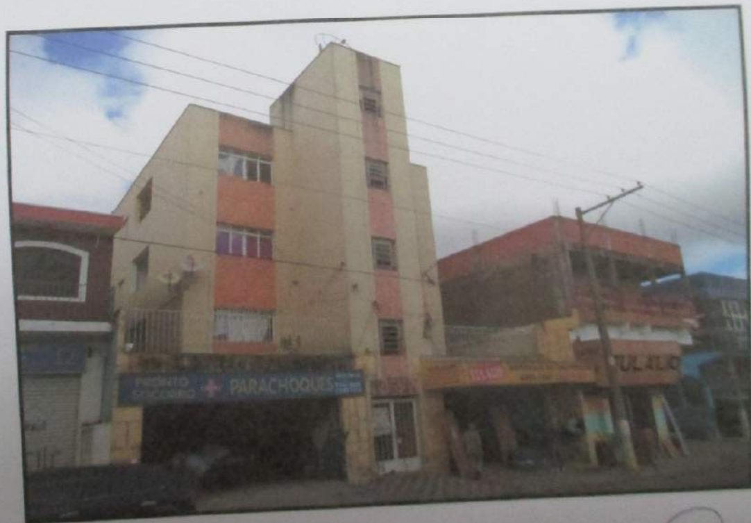
FOTOS 20/21 : Vistas da via pública e do imóvel vistoriado.
