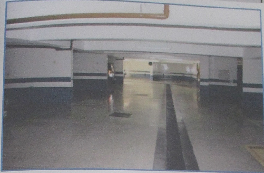
VISTA GERAL DO ESTACIONAMENTO POR OUTRO ÂNGULO.
