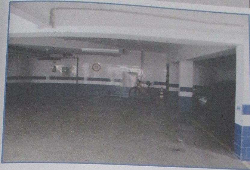
VISTA GERAL DO ESTACIONAMENTO.
