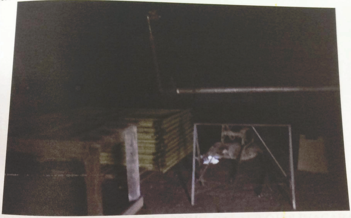
FOTO-12- VISTA INTERNA DO SHOPPING, NIVEL TÉRREO INACABADO .
