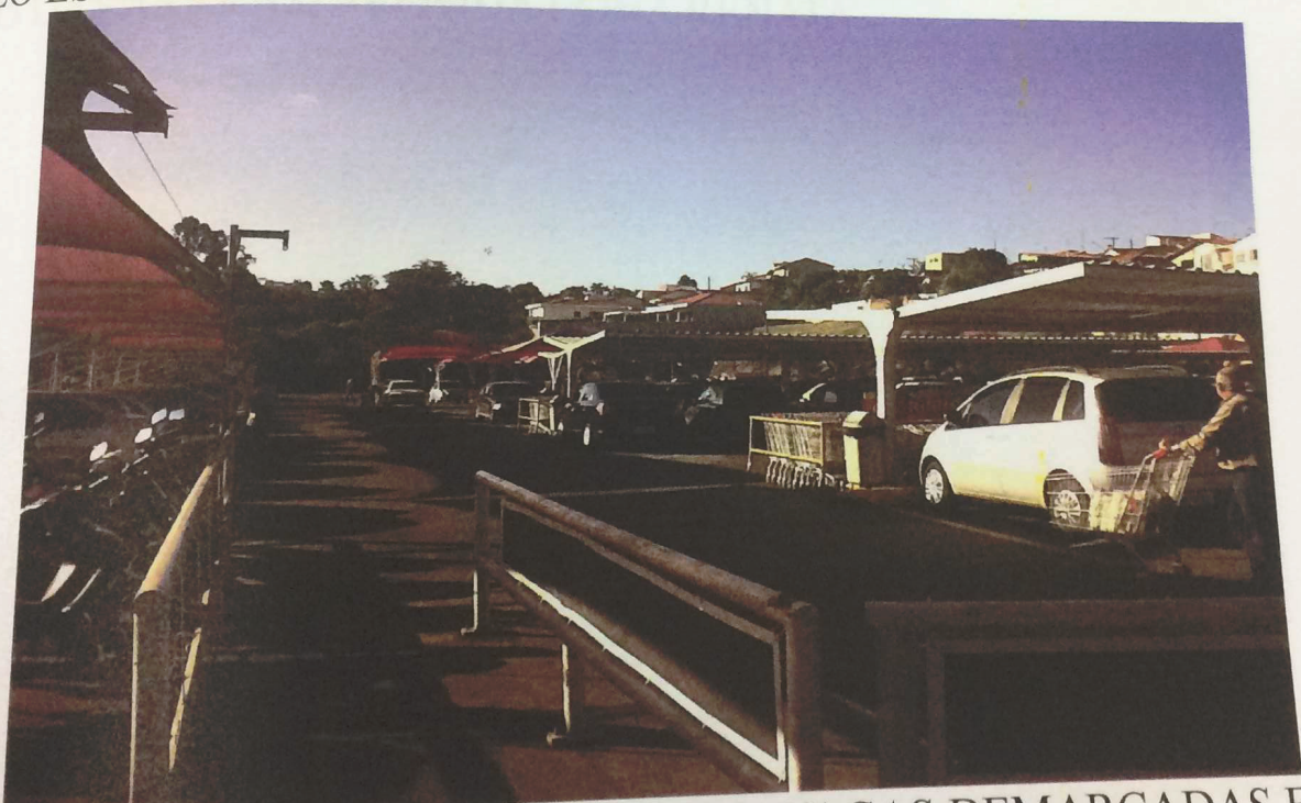
FOTO-08-VISTA DO ESTACIONAMENTO, VAGAS DEMARCADAS E COBERTURAS DAS MESMAS.
