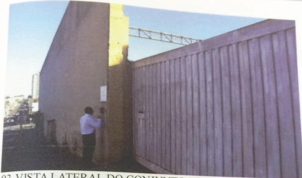
FOTO-03-VISTA LATERAL DO CONJUNTO PELA RUA LINS, PORTÃO ACESSO ÀS DOCAS DO HIPERMERCADO TIRADENTES.
