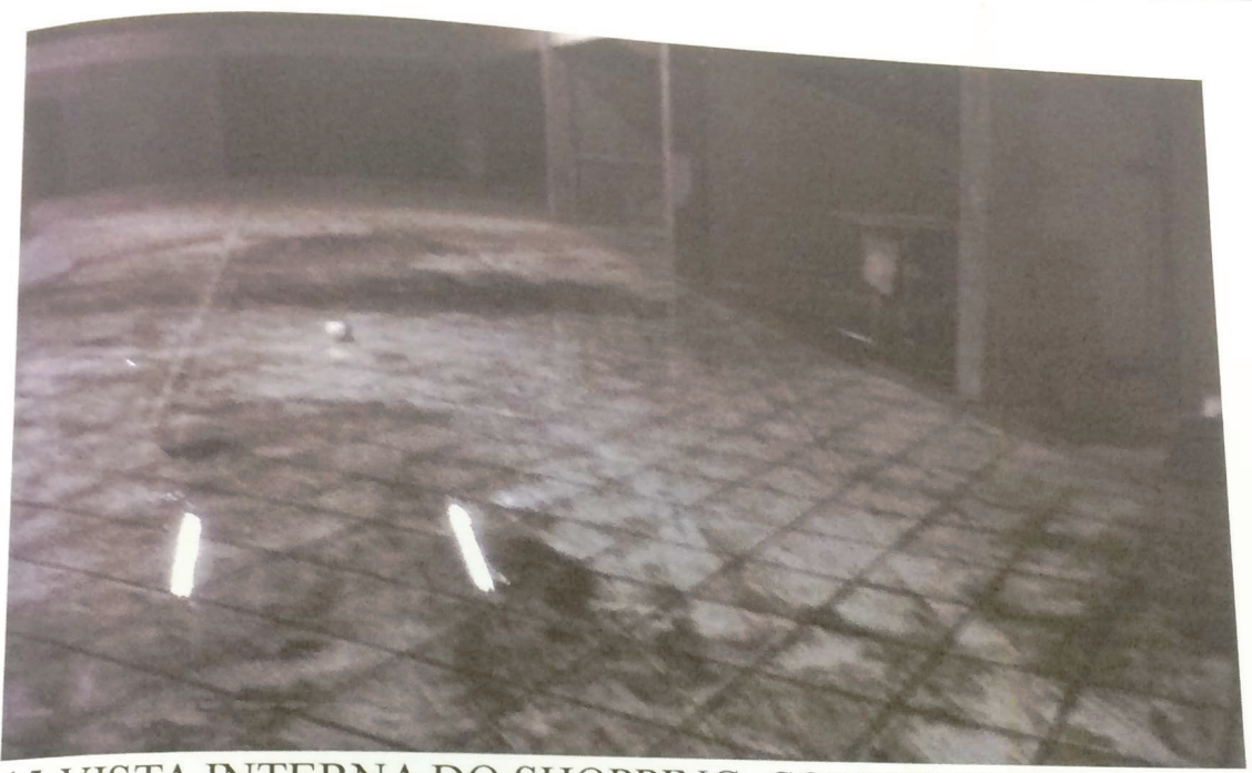
FOTO-15-VISTA INTERNA DO SHOPPING, CORREDOR INACABADO COM VAZAMENTOS DE ÁGUAS PLUVIAIS DA COBERTURA .
