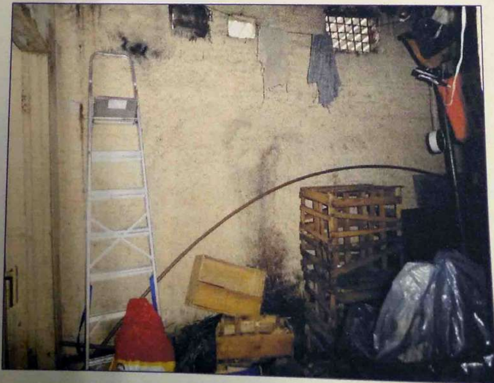
SALÃO COMERCIAL - DEPÓSITO.
