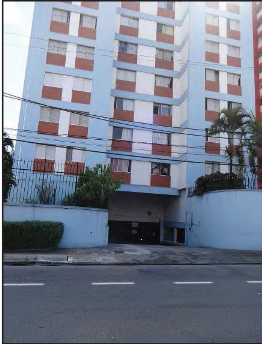
VISTA DA ENTRADA E SAÍDA DE GARAGEM DO "EDIFÍCIO EVA SERSON, TOMADA PELA RUA DOM AMARAL MOUSINHO.
