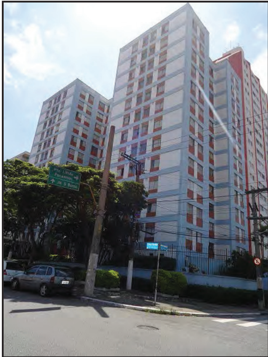
VISTA DA FACHADA DO EDIFÍCIO EVA SERSON. TOMADA PELA AVENIDA CASA VERDE.
