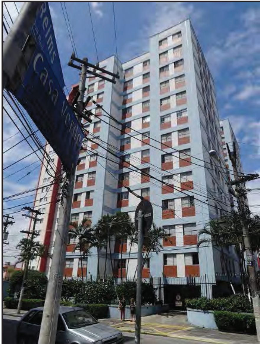
VISTA DA FACHADA DO "EDIFÍCIO EVA SERSON, TOMADA PELA RUA REIMS.
