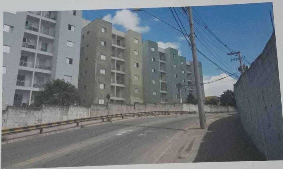
VISTAS DA ESTRADA DO ZIRCÔNICO QUE DIVIDE O IMÓVEL AVALIANDO
