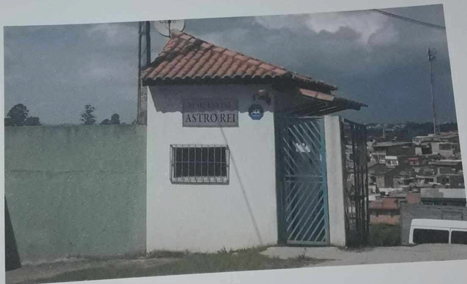
VISTAS DAS ENTRADAS PRINCIPAIS ONDE SE SITUA O IMÓVEL AVALIANDO
