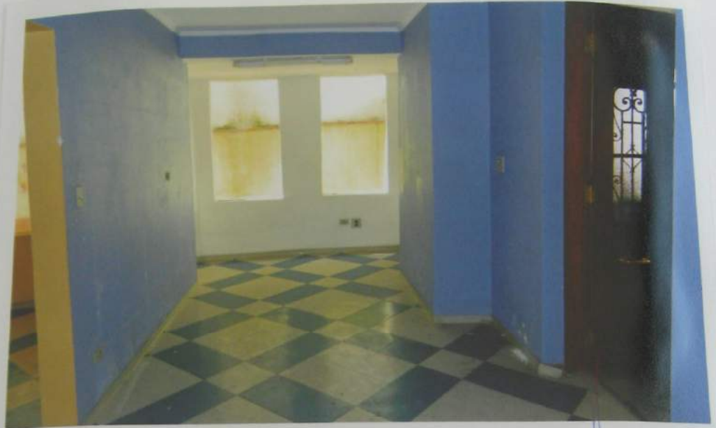
Foto de nº 10 - Vista da sala - III (piso térreo).
