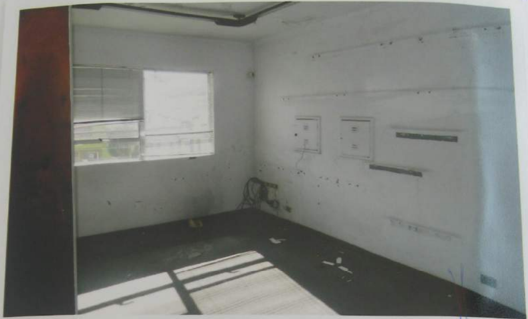
Foto de nº 12 - Vista da sala - V (piso superior)..
