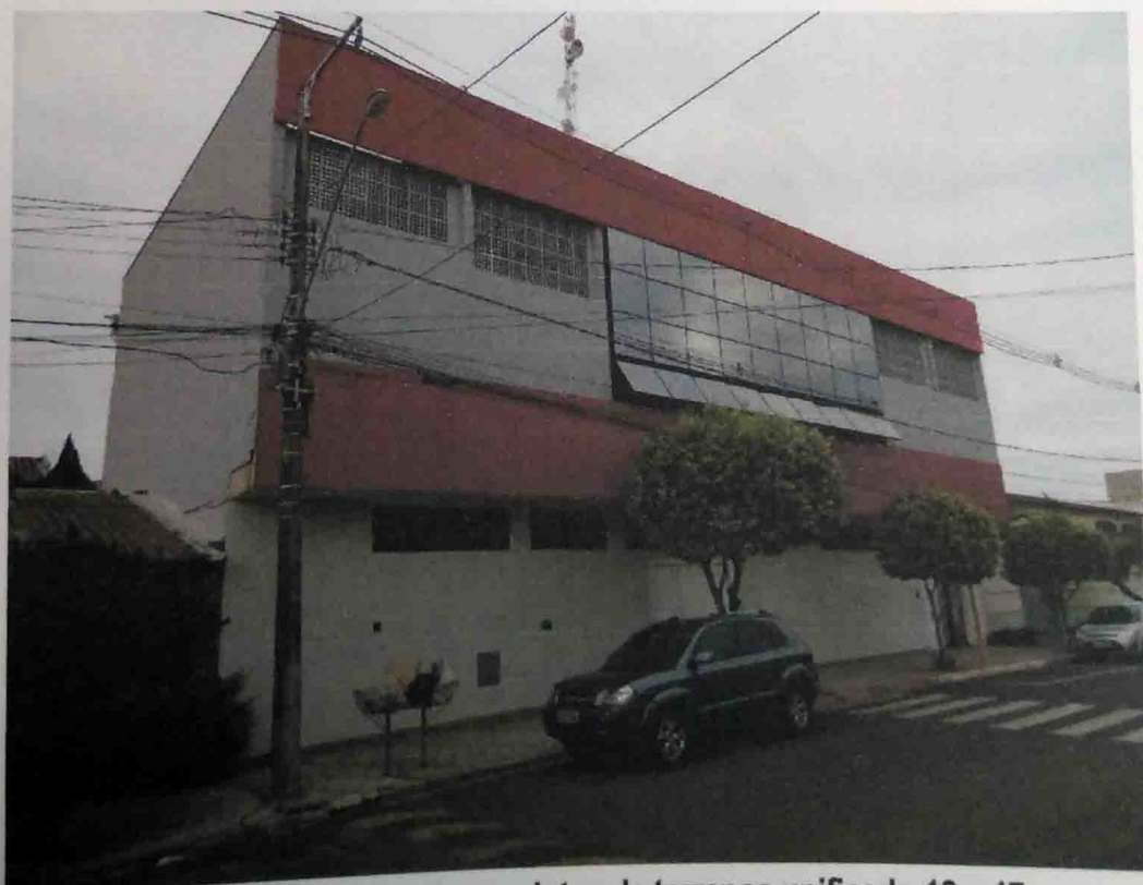
Foto 02. Prédio construído sobre os lotes de terrenos unificado 18 e 17.
