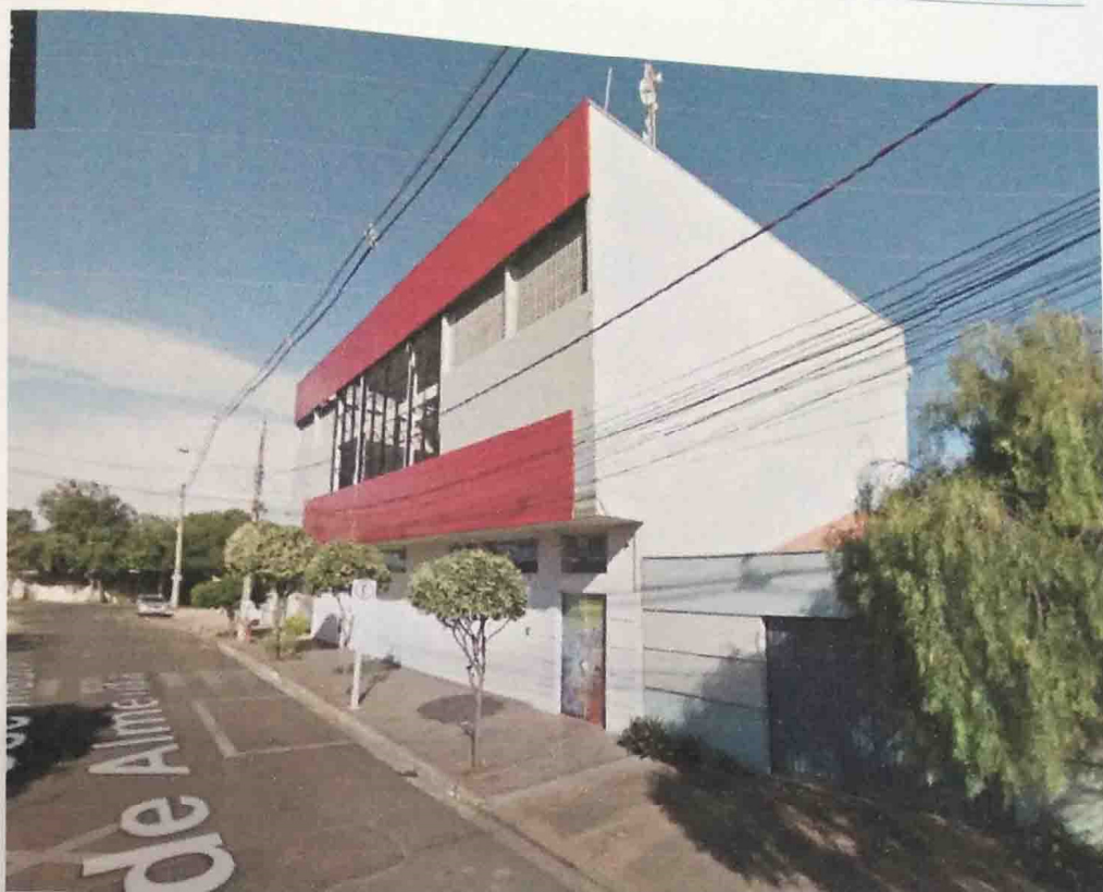
Foto 01. Prédio construído sobre os lotes de terrenos unificado 18 e 17.
