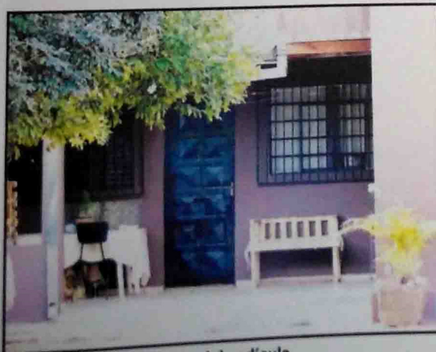
Foto 04. Elevação principal da edícula
