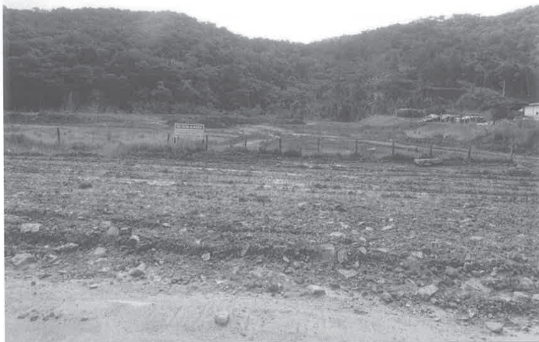
ÁREA CONFRONTANTE EM FASE DE TERRAPLANAGEM E PROPRIETARIO CONSULTADO CUSTOS DE CORTE E MOVIMENTAÇÃO DE SOLO PARA PREVISÃO DE ATERROS E APROVEITAMENTO DA ÁREA AVALIANDA.
