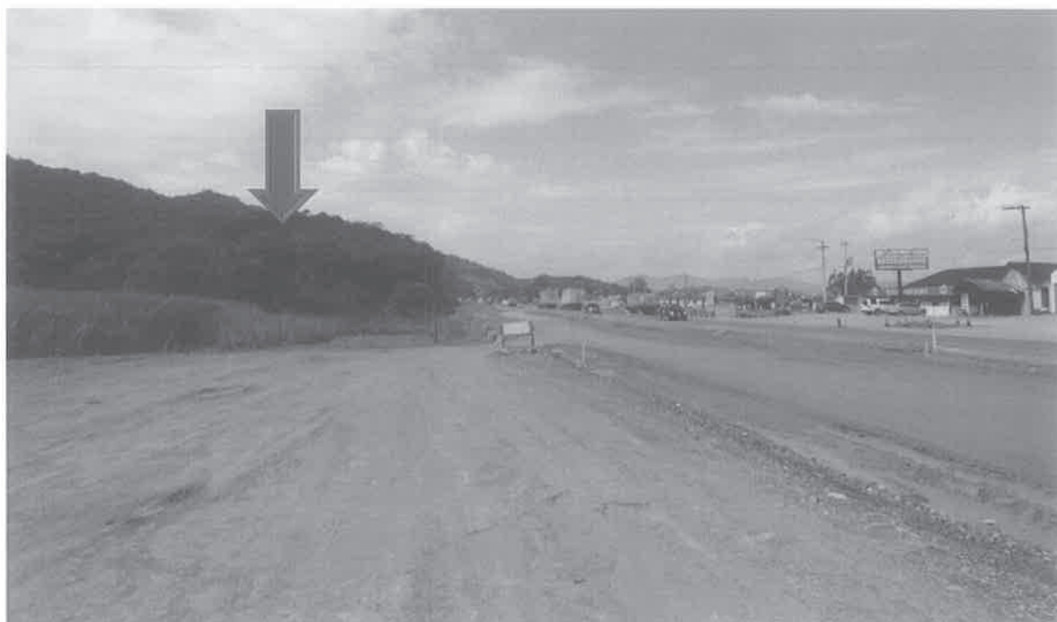
ASPECTO DA TOPOGRAFIA ONDULADA COM NECESSIDADE DE SERVIÇOS DE TERRAPLANAGEM
