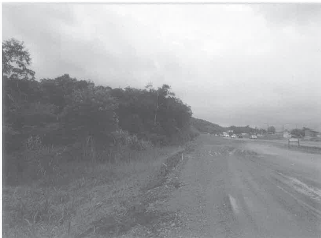
MARCAÇÃO PIQUETES NA LINHA DA RODOVIA FRENTE A ÁREA AVALIANDA
