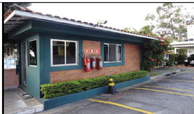
Guarita com banheiro – Portão nº 2
