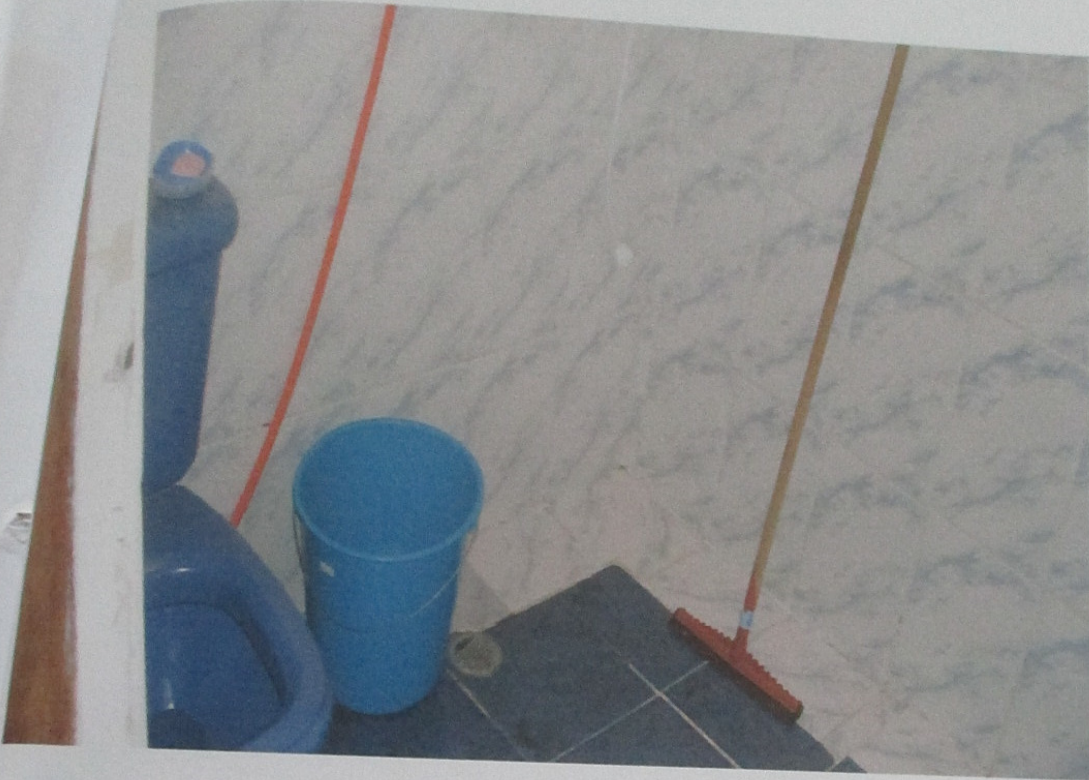
Foto 08 – Vista do banheiro.
