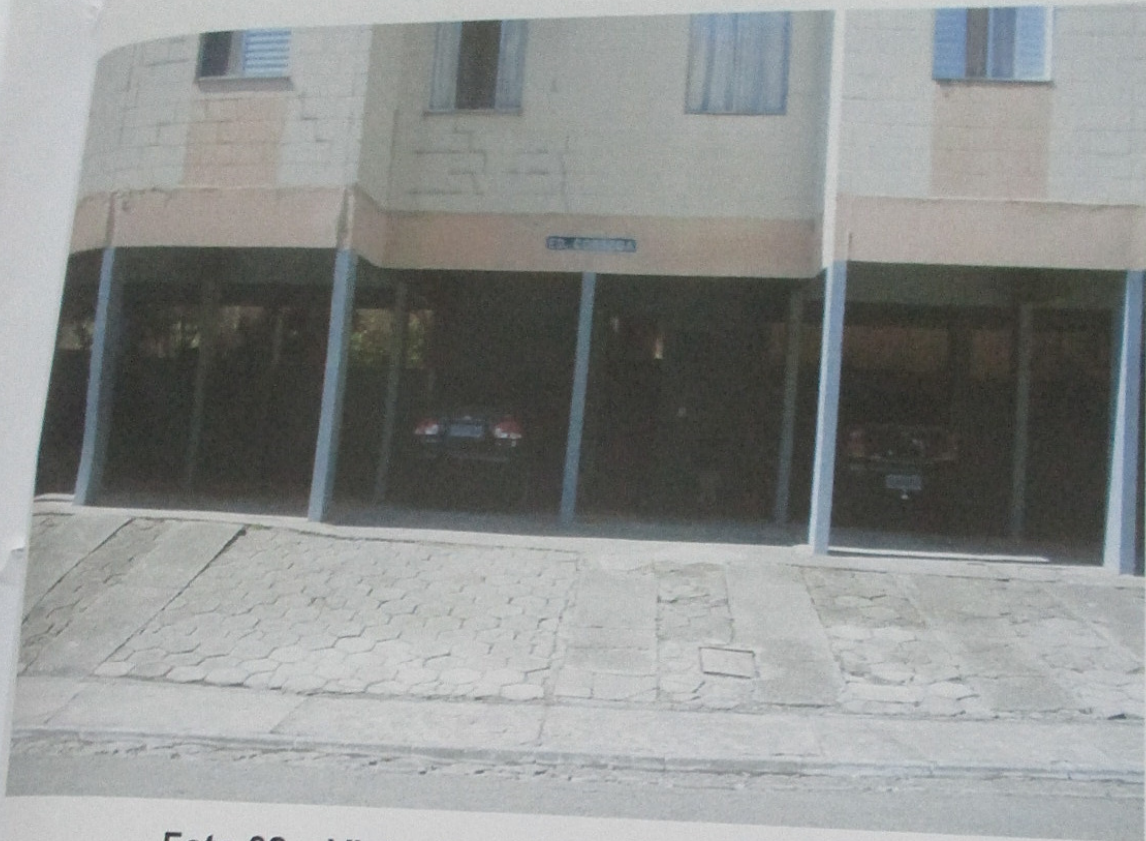
Foto 02 – Vista da entrada do Ed. Corsega.
