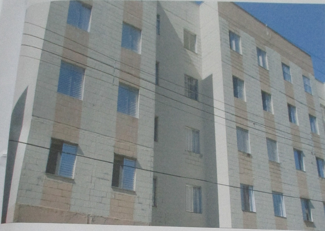
Foto 03 – Vista geral das fachadas do condomínio.
