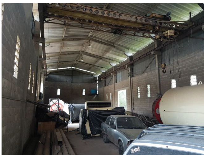
FOTO Nº 07 Vista parcial interior do galpão Fábrica 2
