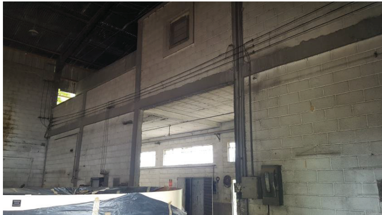
FOTO N° 13 Vista parcial dependência no interior do galpão Fábrica 1
