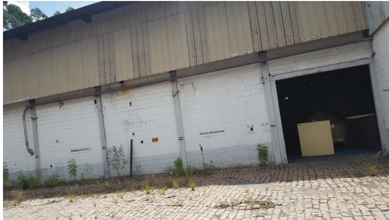
FOTO Nº 09 Vista parcial galpão denominado Fábrica 1 Ano de Construção 1979
