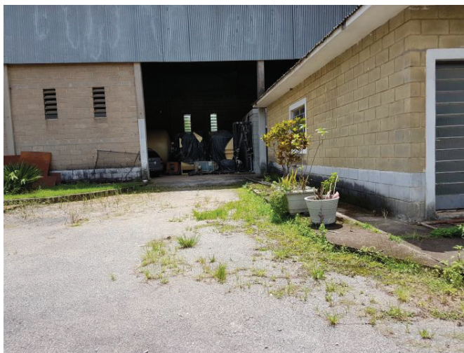
FOTO Nº 06 Vista parcial galpão Fábrica 2
