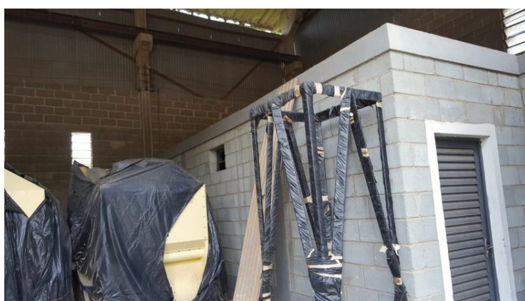
FOTO Nº 08 Vista parcial dependência no interior do galpão Fábrica 2
