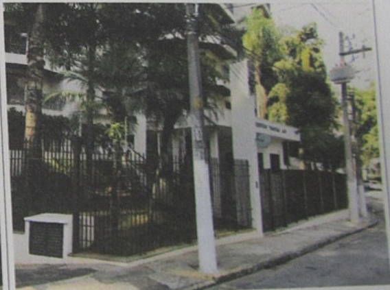
Foto 4: Perspectiva da fachada do Edifício
