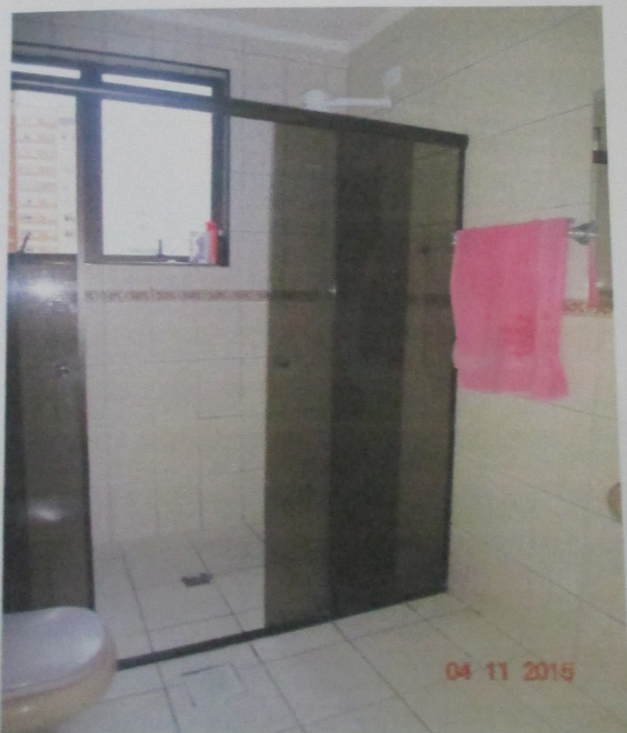
FOTO 20: Vista parcial do banheiro social.
