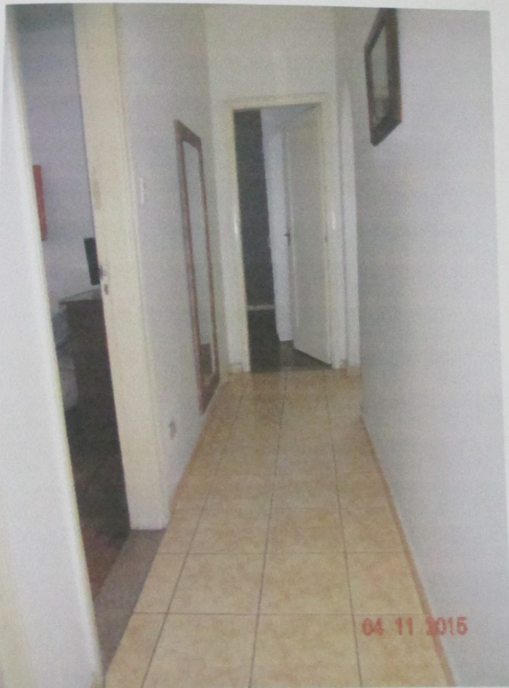
FOTO 16: Vista parcial do corredor de distribuição interna do apartamento avaliando.
