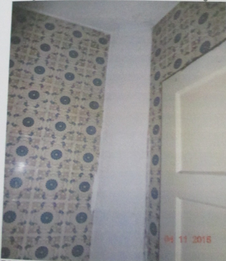
FOTO 28: Vista da outra lateral também com execução de reparos.
