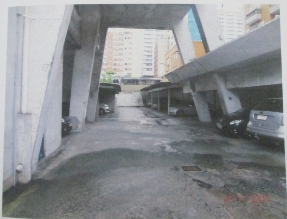
FOTO 08: Vista da área correspondente ao recuo de fundos do edifício, destinada às garagens de autos.
