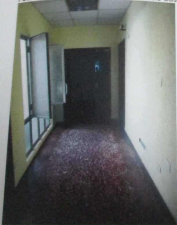
Foto 5: Vista do hall do 5º andar.
