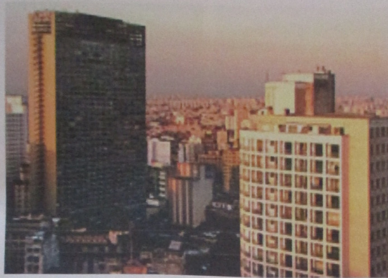
Fotos 1 e 2: Vista do Edifício Mirante do Vale
