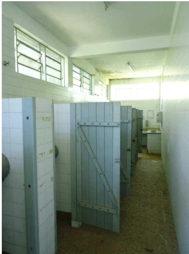
VISTA DO VESTIÁRIO PARA FUNCIONÁRIOS.
