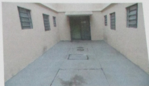
Figura 4 - Área de circulação do Bloco "29", onde inserido o apartamento avaliando.
