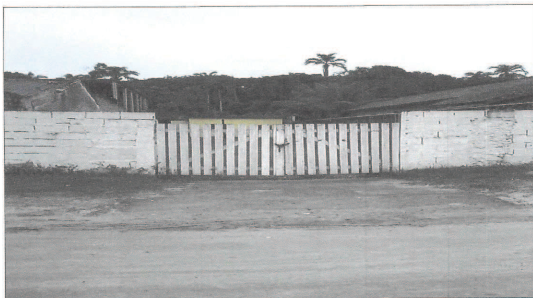
Foto 1 – Vista da fachada frontal do imóvel
