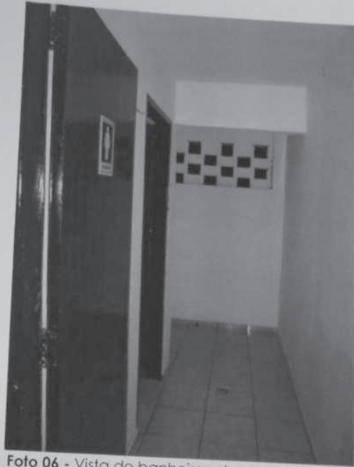
Foto 06 - Vista do banheiro sob o mezanino
