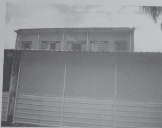
Foto 03 - Vista do imóvel pelos fundos - escritório/mezanino ao alto, compondo a edificação principal e cobertura de fundos.
