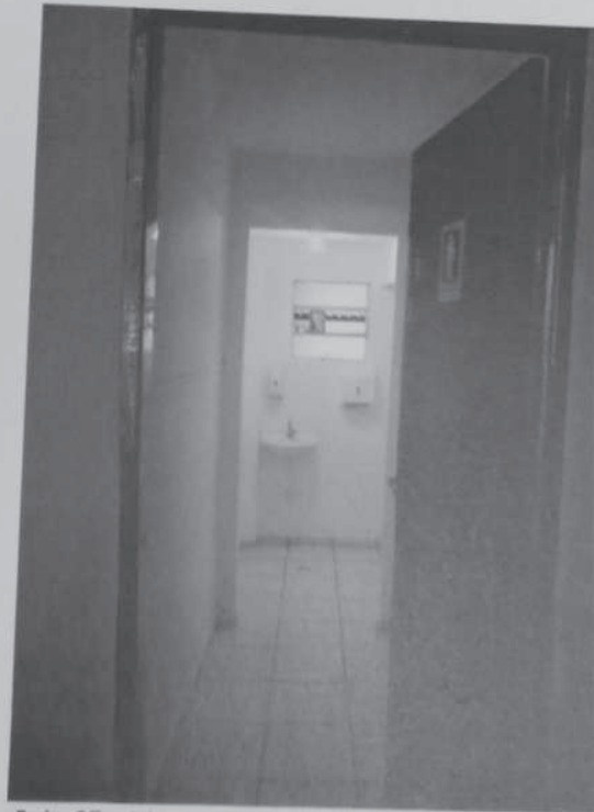
Foto 07 - Idem para o outro banheiro.
