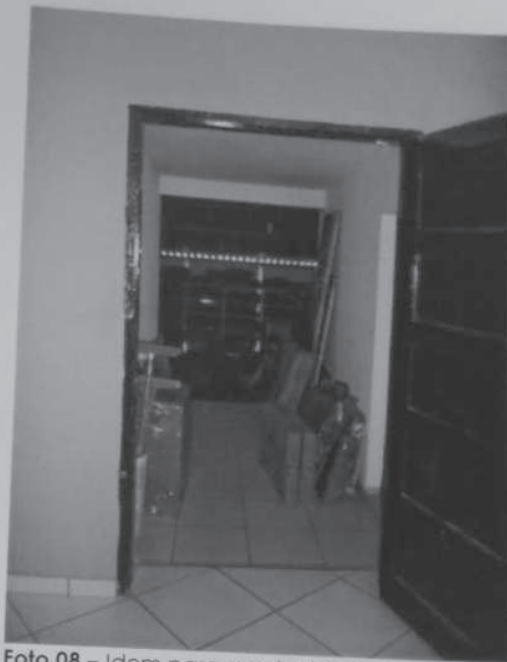
Foto 08 - Idem para o outro banheiro.
