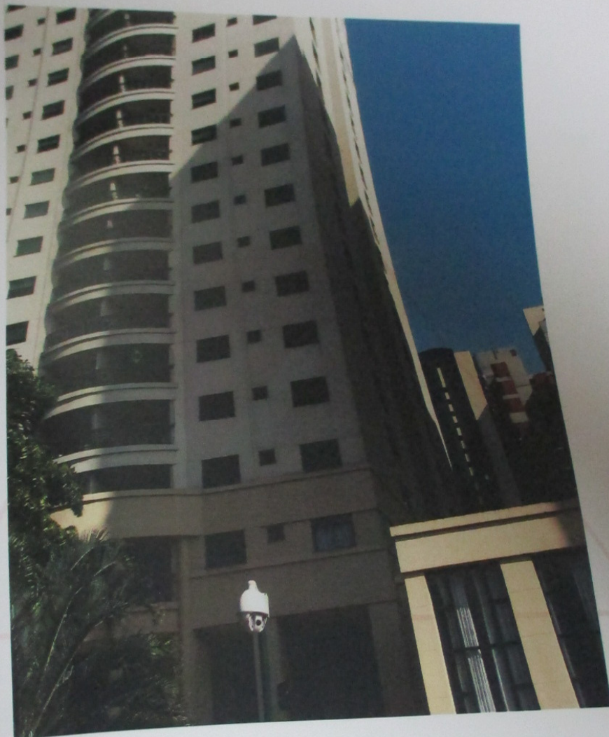
FOTO 5: FACHADA DO EDIFÍCIO.
