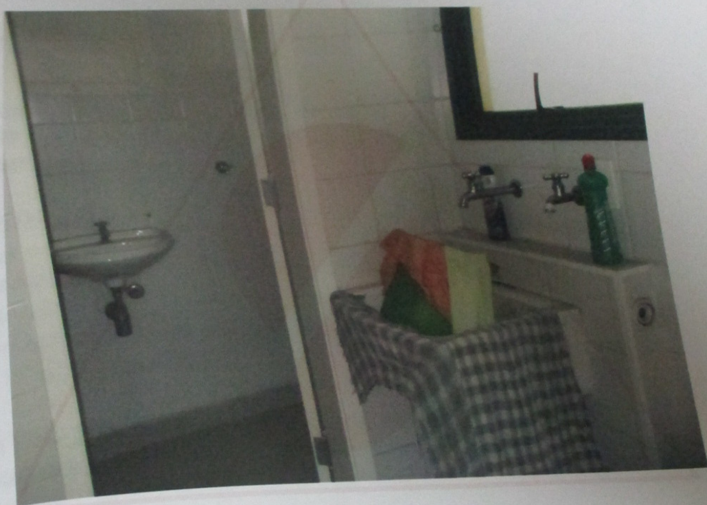
FOTO 22: ÁREA DE SERVIÇO.
