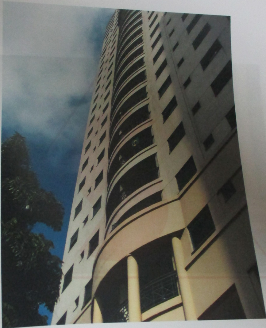
FOTO 6: OUTRA VISTA DA FACHADA.
