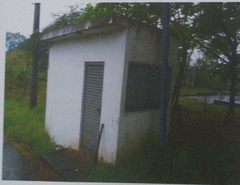
Vista do imóvel em questão.
