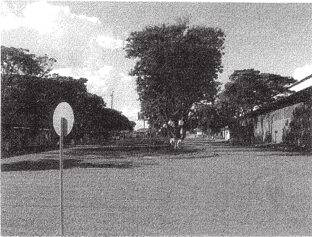
Foto asfalto interno, pátio da empresa.
