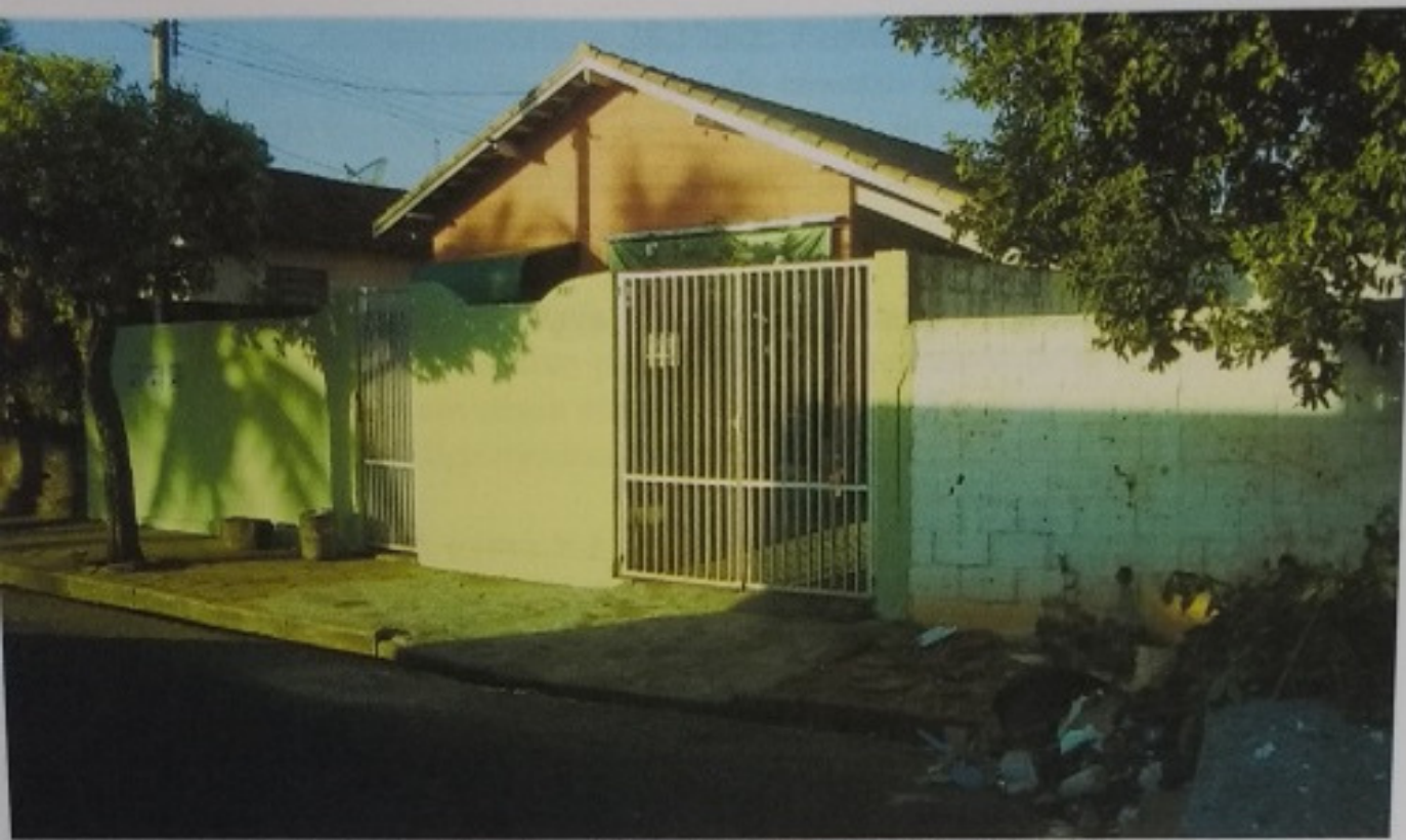
Imóvel avaliando – Vista Frontal da Casa Residencial.
