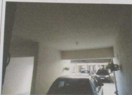
Foto 5 – Outra vista da garagem.
