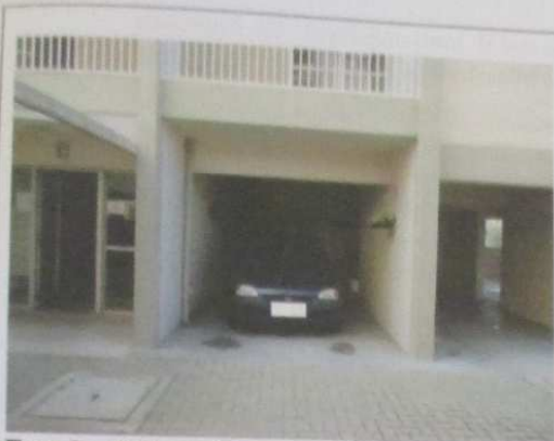
Foto 3 – Vista da Garagem 20C avalianda.
