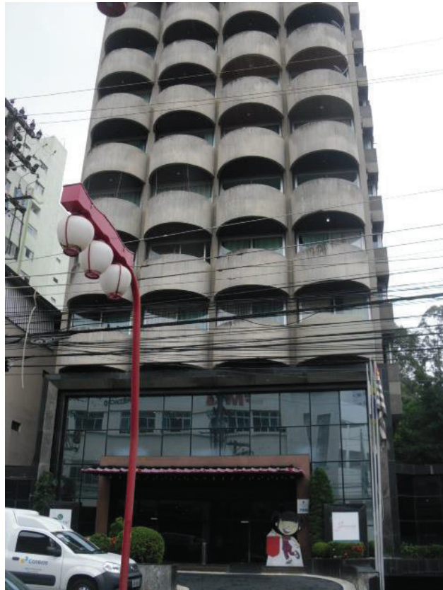
Foto 01 – Frente do imóvel avaliando, Rua Galvão Bueno nº 700
